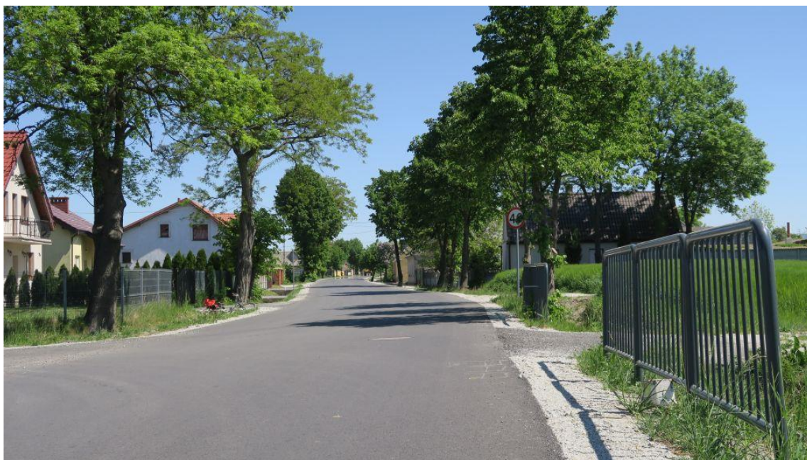
Fot. Przebudowa drogi wewnętrznej w Jedlcu
