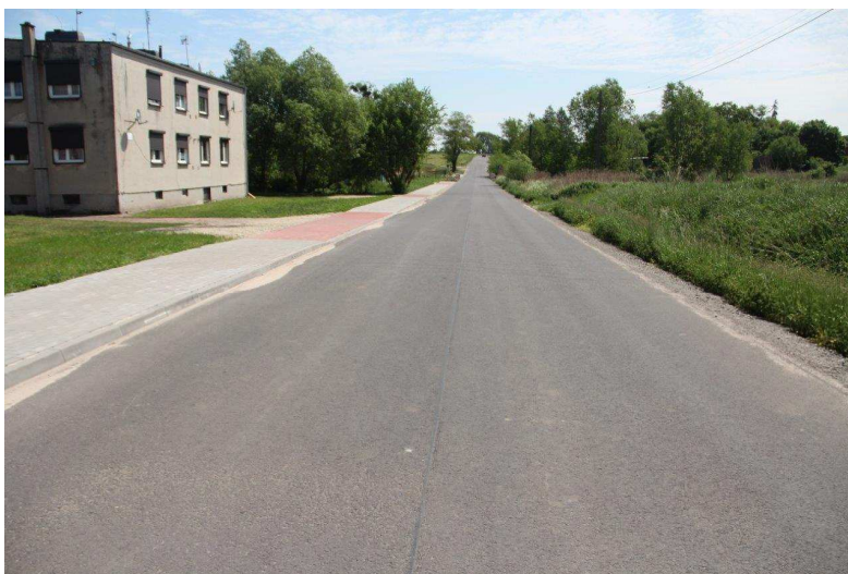
Zdjęcie 5. Budowa drogi gminnej, ul. Wierzbowa w Kościelnej Wsi
