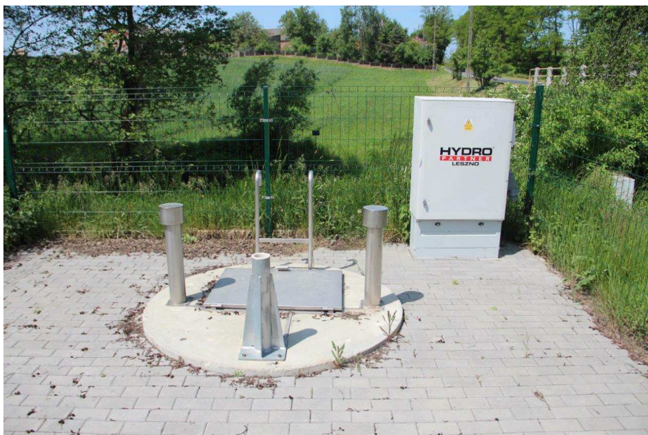
Zdjęcie 6. Budowa kanalizacji sanitarnej w miejscowościach Jedlec i Tursko – etap II oraz modernizacja stacji uzdatniania wody z budową zbiornika retencyjnego w miejscowości Czechel
