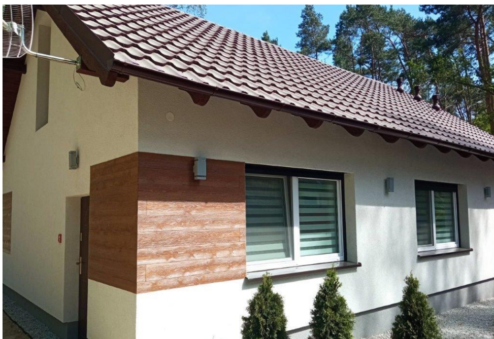
Fot. Przebudowa z rozbudową i nadbudową budynku recepcji w GOTiS
