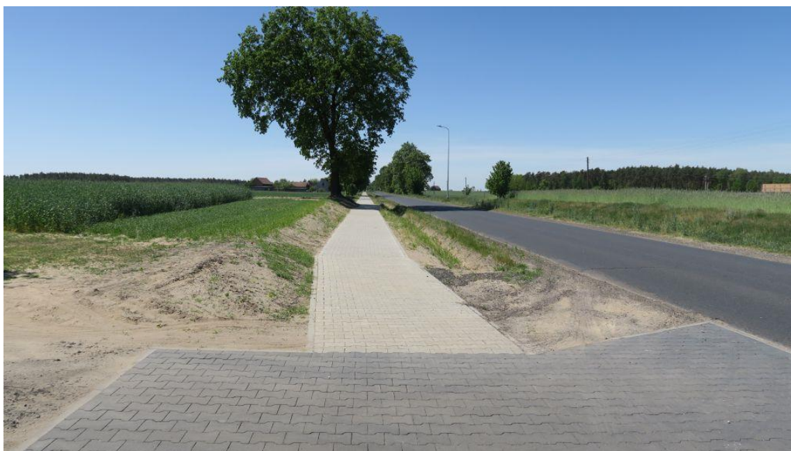
Fot. Przebudowa drogi powiatowej nr 4342P w zakresie budowy ścieżki rowerowej na odcinku Tursko - Bogusław
