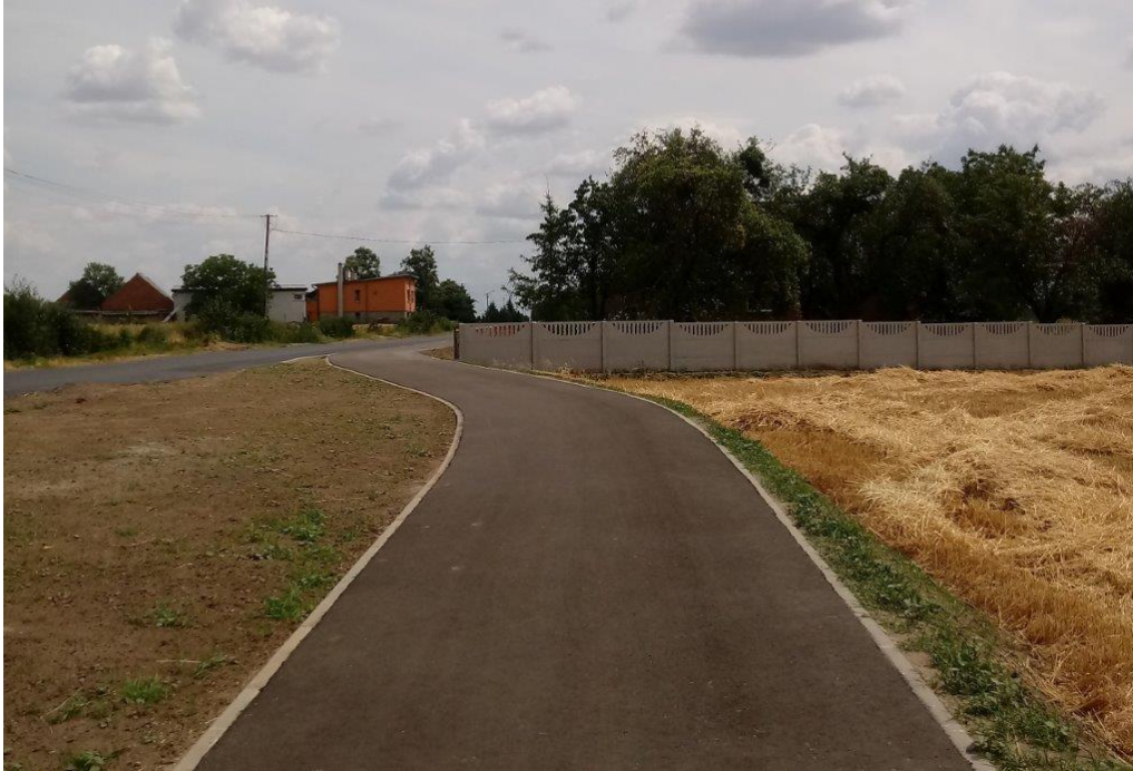
Budowa ścieżki rowerowej wzdłuż drogi powiatowej nr 4348P Krzywosądów-Kucharki
