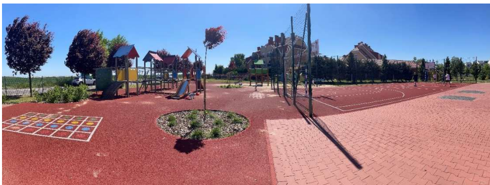
Zdjęcie 9. BUDOWA PLACU ZABAW ORAZ BOISKA SPORTOWEGO NA OSIEDLU ŻŁOTE ŁĄKI W KOŚCIELNEJ WSI
