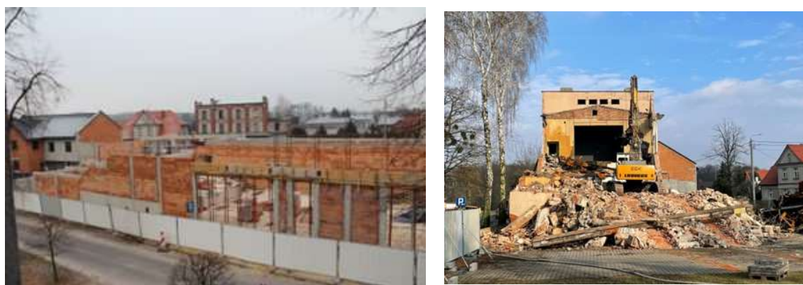
Zdjęcie 7. BUDOWA BUDYNKU GMINNEGO CENTRUM KULTURY I OCHOTNICZEJ STRAŻY POŻARNEJ W GOŁUCHOWIE
