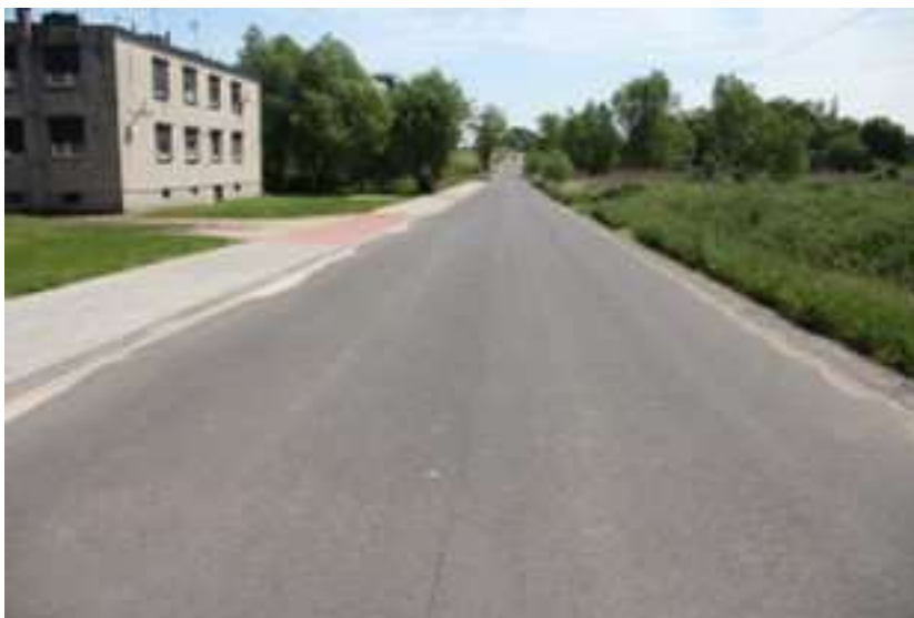
Zdjęcie 3. PRZEBUDOWA DROGI GMINNEJ W SZKUDLI
