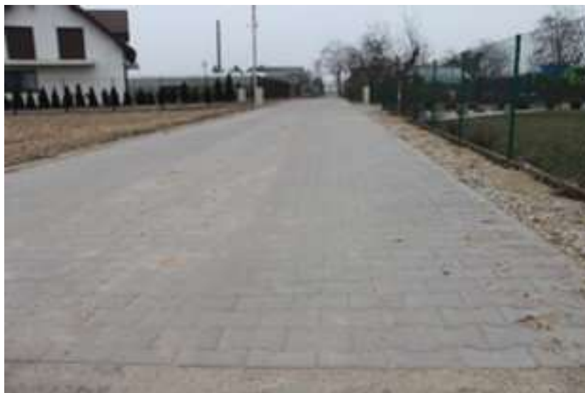
Zdjęcie 4. BUDOWA DROGI WEWNĘTRZNEJ W KUCHARACH (cz. działki 52/2)
