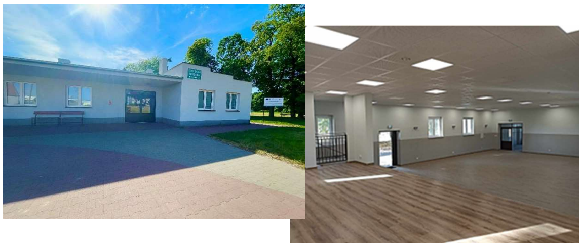
Zdjęcie 6. PRZEBUDOWA SALI WIEJSKIEJ W CZERMINKU
