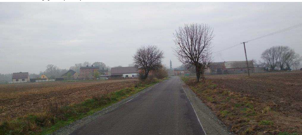
Przebudowa drogi gminnej w miejscowości Szkudła
