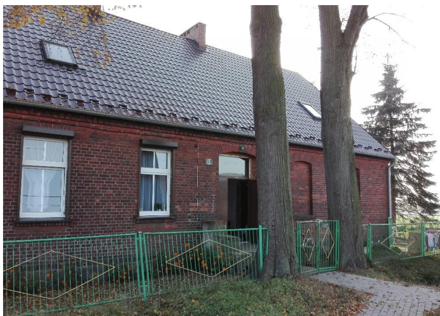
Rysunek 2. Budynek komunalny w Kajewie Źródło: Urząd Gminy Gołuchów
