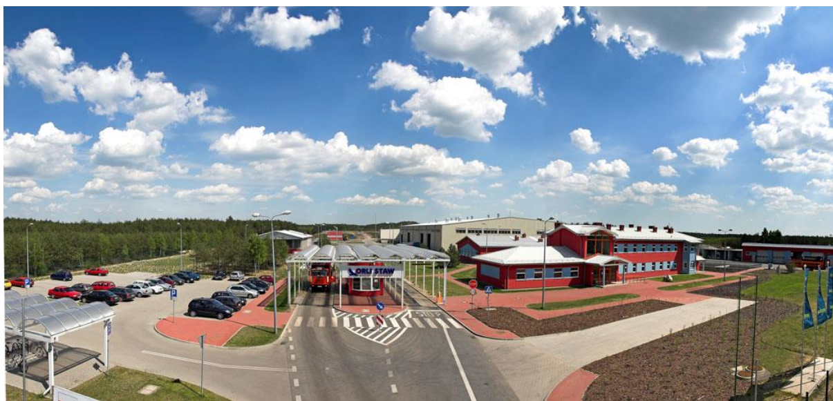
Fotografia 1. Zakład Unieszkodliwiania Odpadów Komunalnych „Orli Staw”
