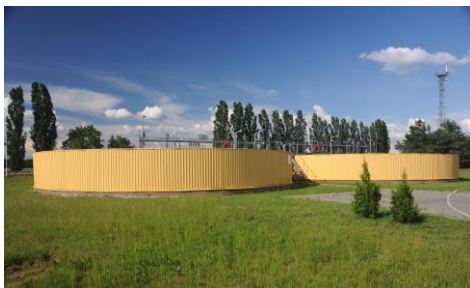
4, 5. Oczyszczalnia ścieków w Gołuchowie. Fot. T. Marcinkowski.
