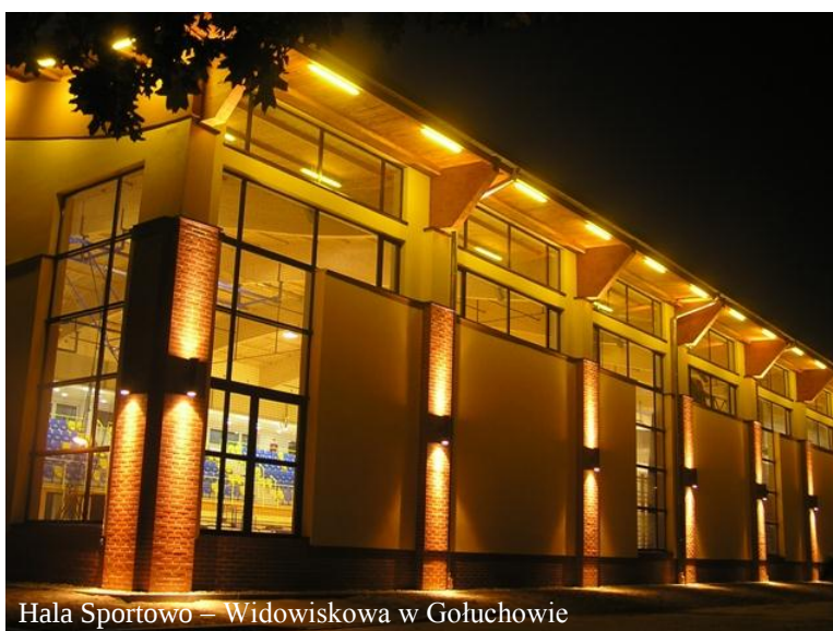
Budowa Hali Sportowo – Widowskiej w Gołuchowie
