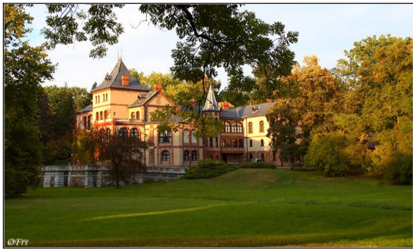
Budynek Oficyny w parku
