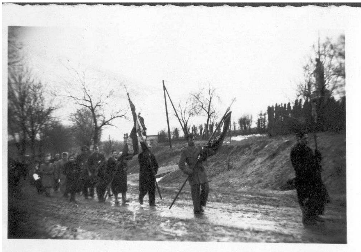
Rys. 3 Główna droga przed remontem
