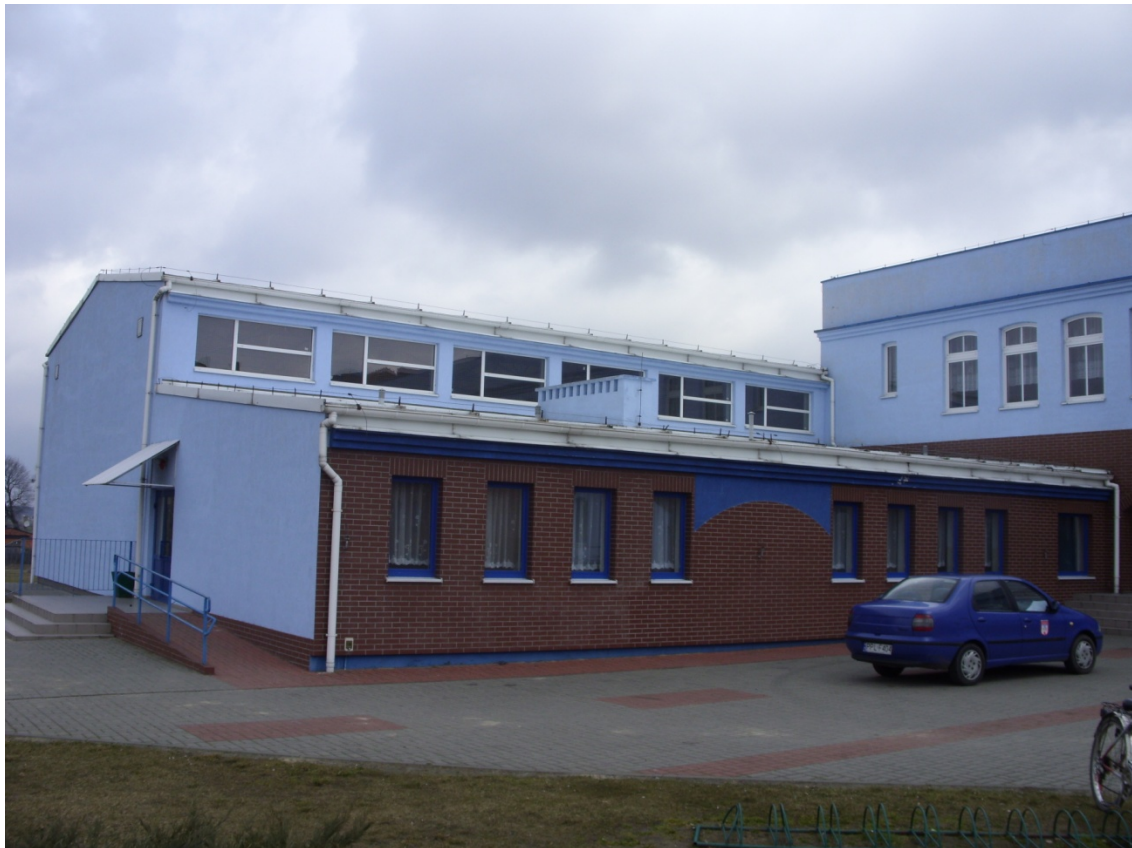
Rys. 5 Sala gimnastyczna z zapleczem
