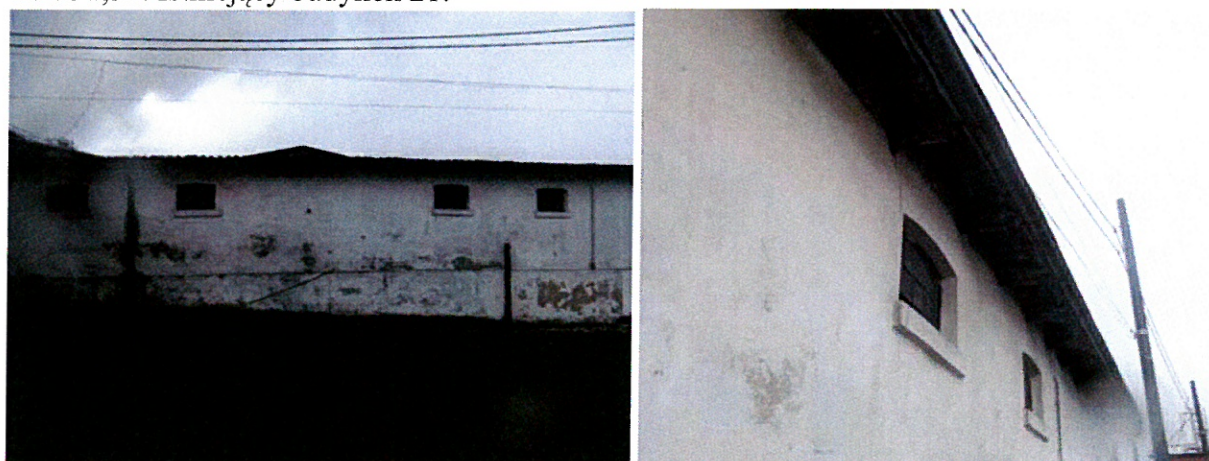
Fot. 31,32. Istniejący budynek 21:
