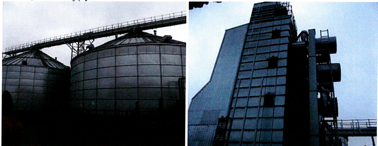
Fot. 25, 26. Istniejący obiekt 18:
