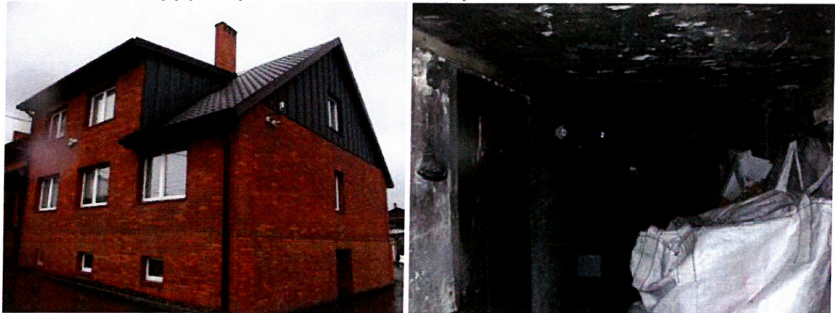
Fot. 24. Istniejący obiekt 17:
