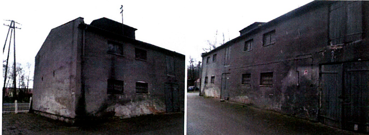
Fot. 27, 28. Istniejący budynek 19:
