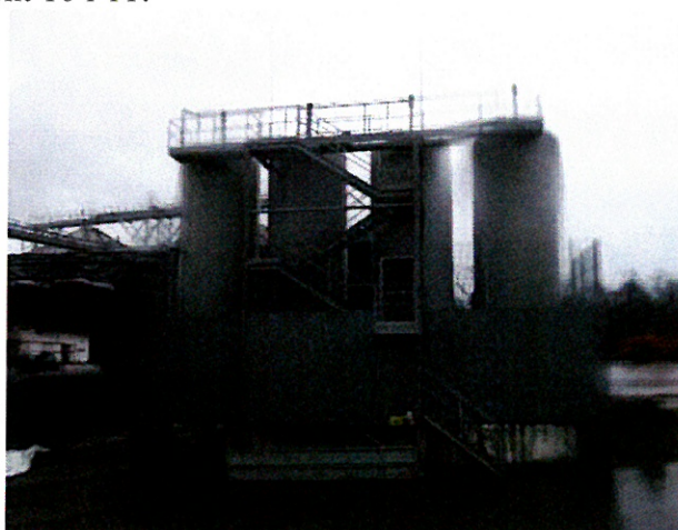
Fot. 16. Istniejący obiekt 10 i 11:
