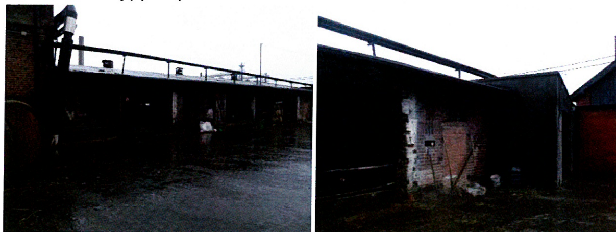
Fot. 29, 30. Istniejący budynek 20:
