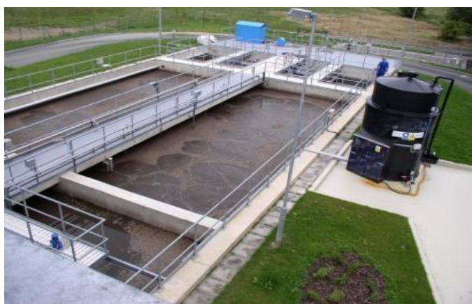
Przykładowy reaktor / zbiornik procesów tlenowych
