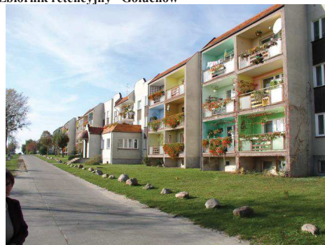
Fot. 32. Gołuchów – budynek wielorodzinny
