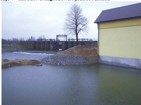
Fot. 23. Kościelna Wieś – elektrownia wodna przy Prośnie
