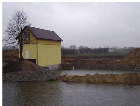
Fot. 22. Kościelna Wieś – elektrownia wodna przy Prośnie
