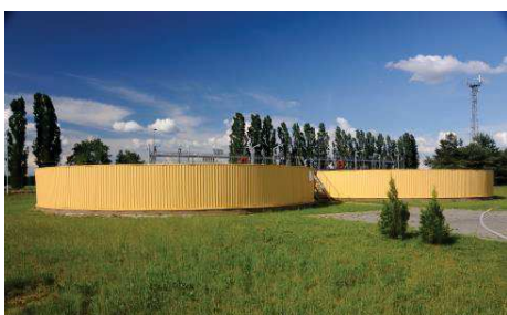
4, 5. Oczyszczalnia ścieków w Gołuchowie. Fot. T. Marcinkowski.
