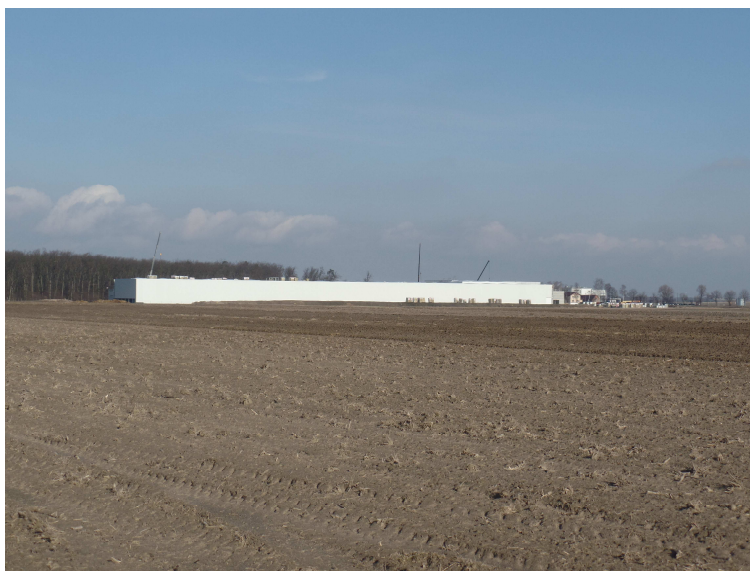
Fot. 2. Budowa wielkopowierzchniowego obiektu produkcyjno-magazynowego (widok w kierunku północno-wschodnim)
