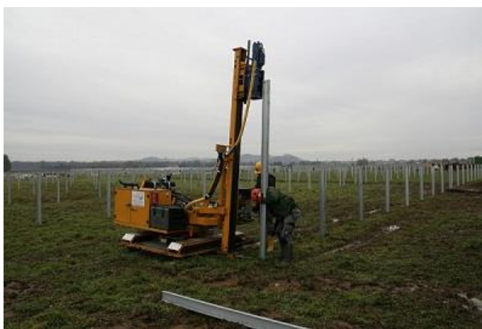
Fot. 9. Wbijanie konstrukcji wsporczych ogniw fotowoltaicznych
