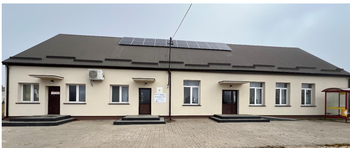
Modernizacja świetlicy wiejskiej w Bolewie
