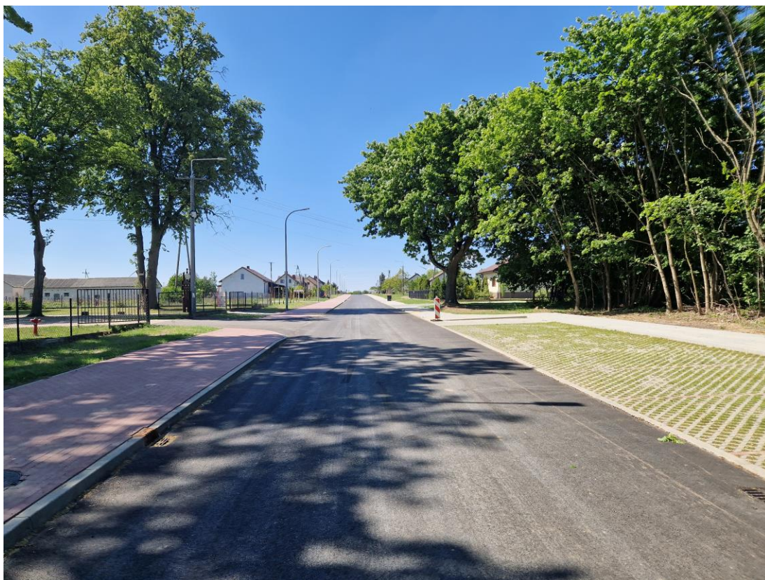
Przebudowa drogi gminnej w miejscowości Wyszyny Kościelne
