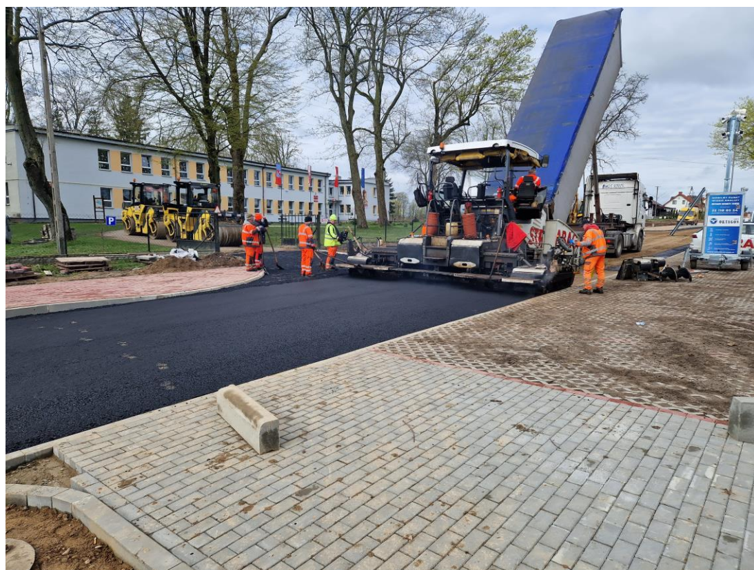
Przebudowa drogi gminnej w miejscowości Wyszyny Kościelne
