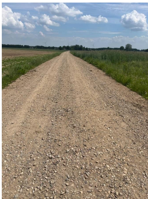
Przebudowa drogi gminnej Zdroje - Wyszyń Kościelne
