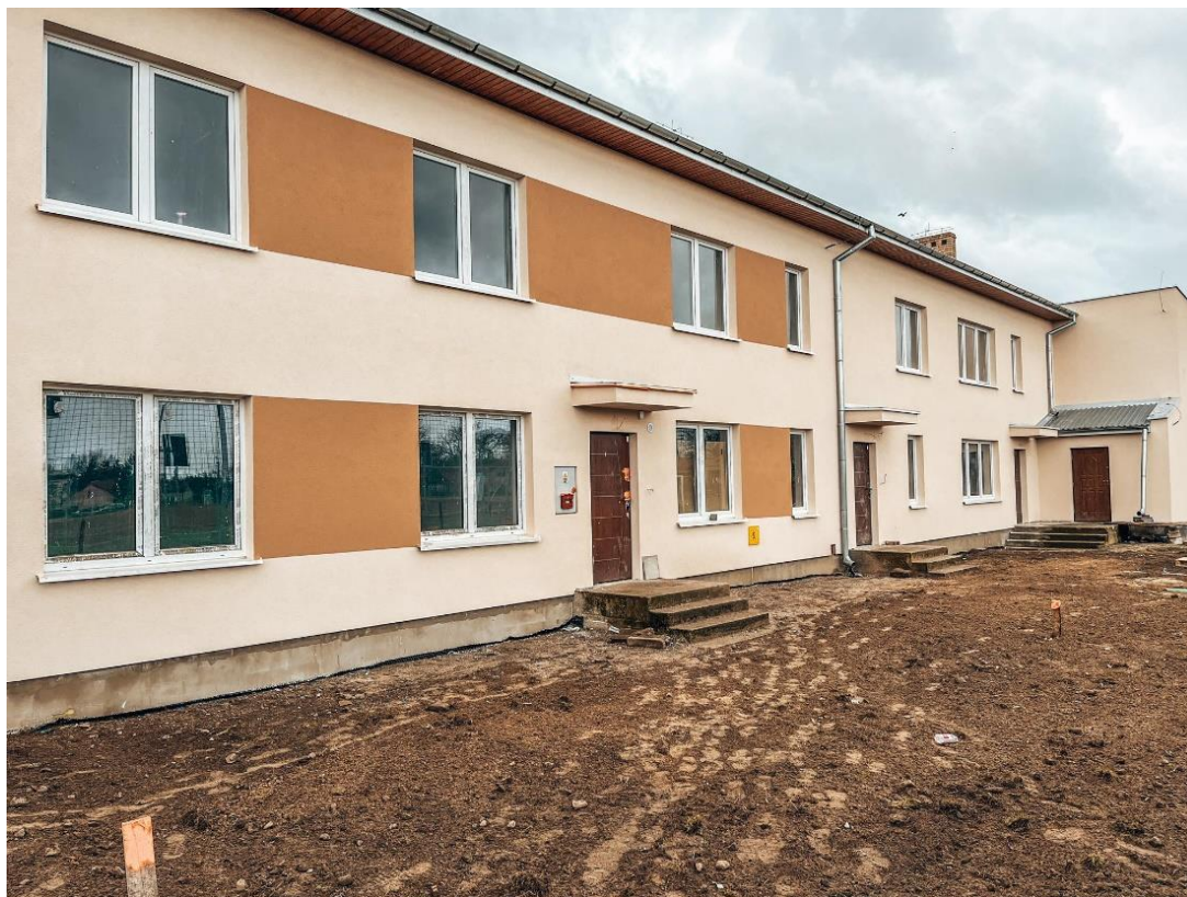
Prace budowlane w budynek Gminnego Ośrodka Kultury w Konopkach
