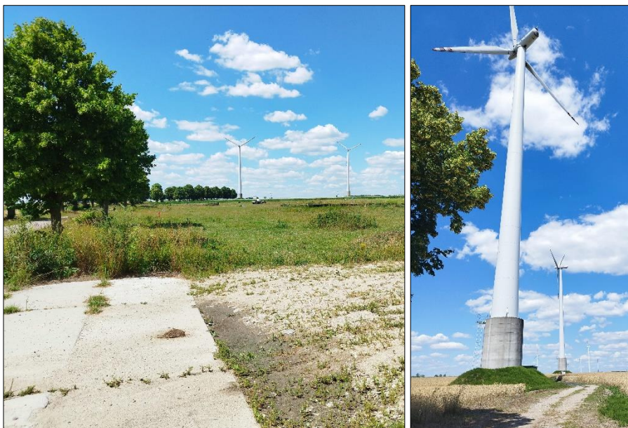
Fot. 1 Istniejące elektrownie wiatrowe na dz. nr 50, obr. Zdroje
