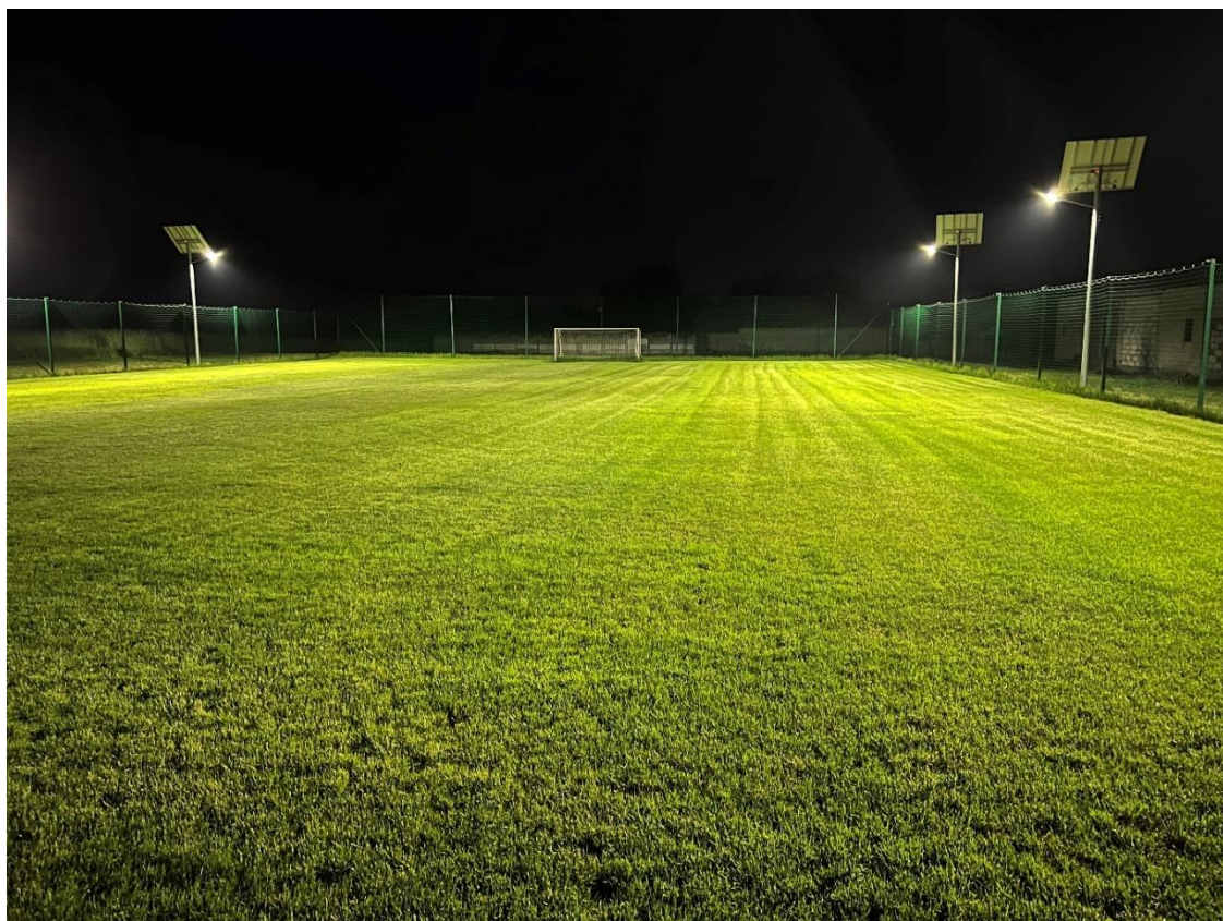
Oświetlenie boiska sportowego w miejscowości Wola Szydłowska
