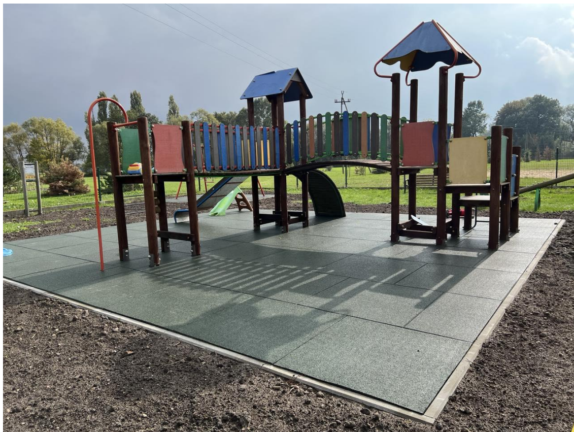
Wykonanie bezpiecznej nawierzchni na placu zabaw w Strzałkowie.
