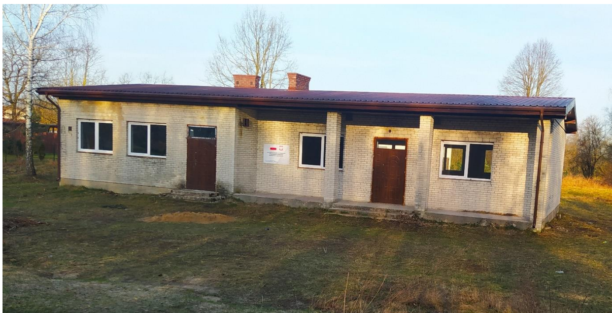
Świetlica wiejska w Żmijewo-Gaje po pierwszym etapie prac
