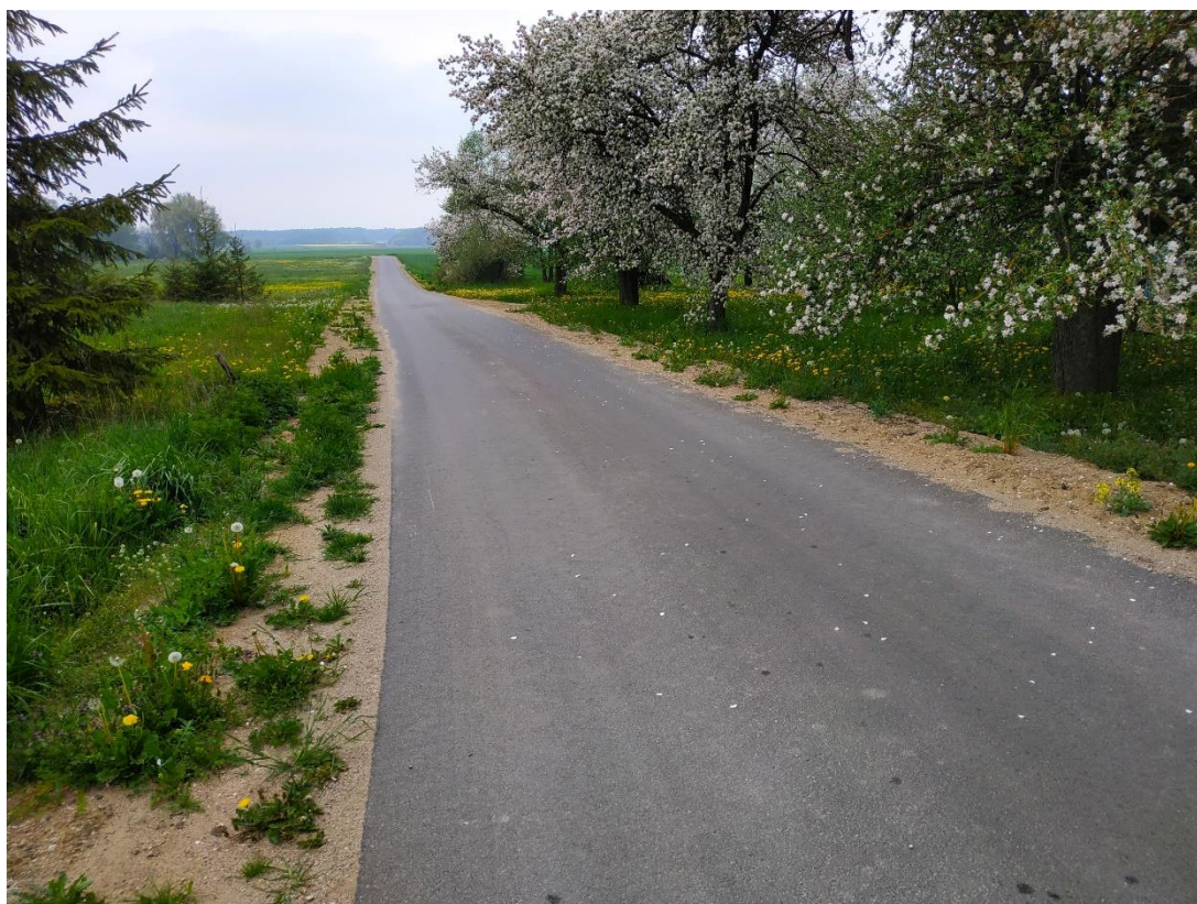
Przebudowa drogi gminnej Olszewo Borzymy – Olszewo Bołęki
