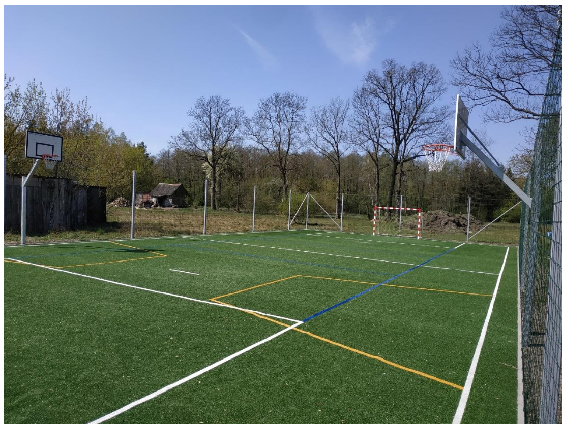
Budowa boiska sportowego w miejscowości Bolewo
