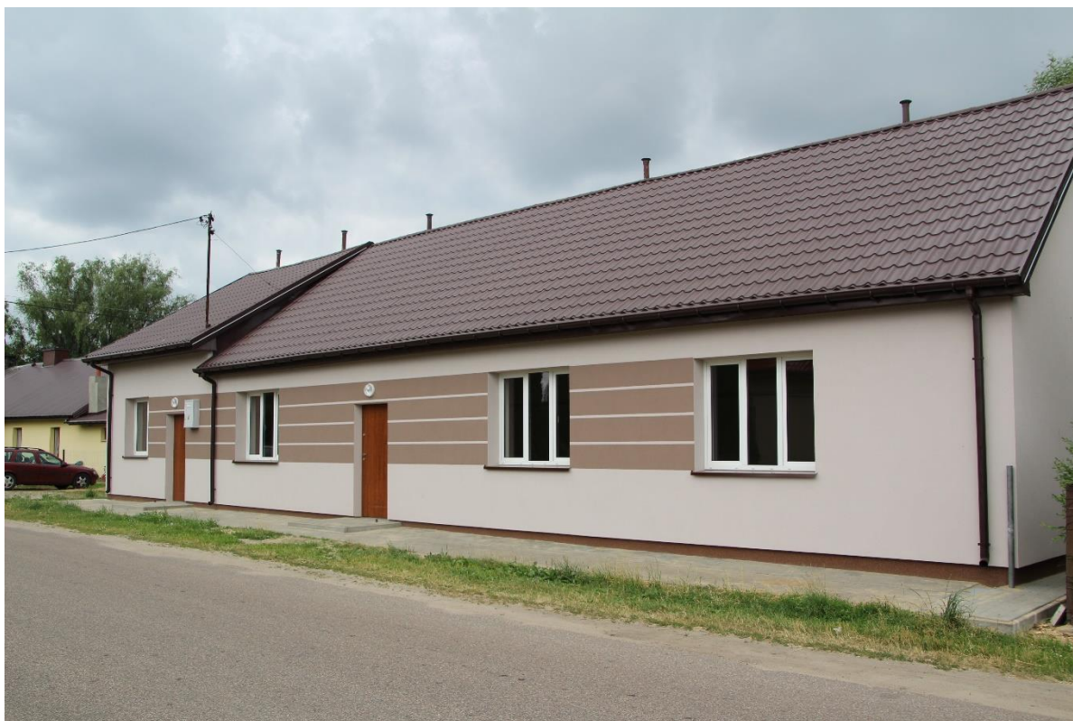
Modernizacja wraz z termomodernizacją świetlicy wiejskiej w Strzałkowie
