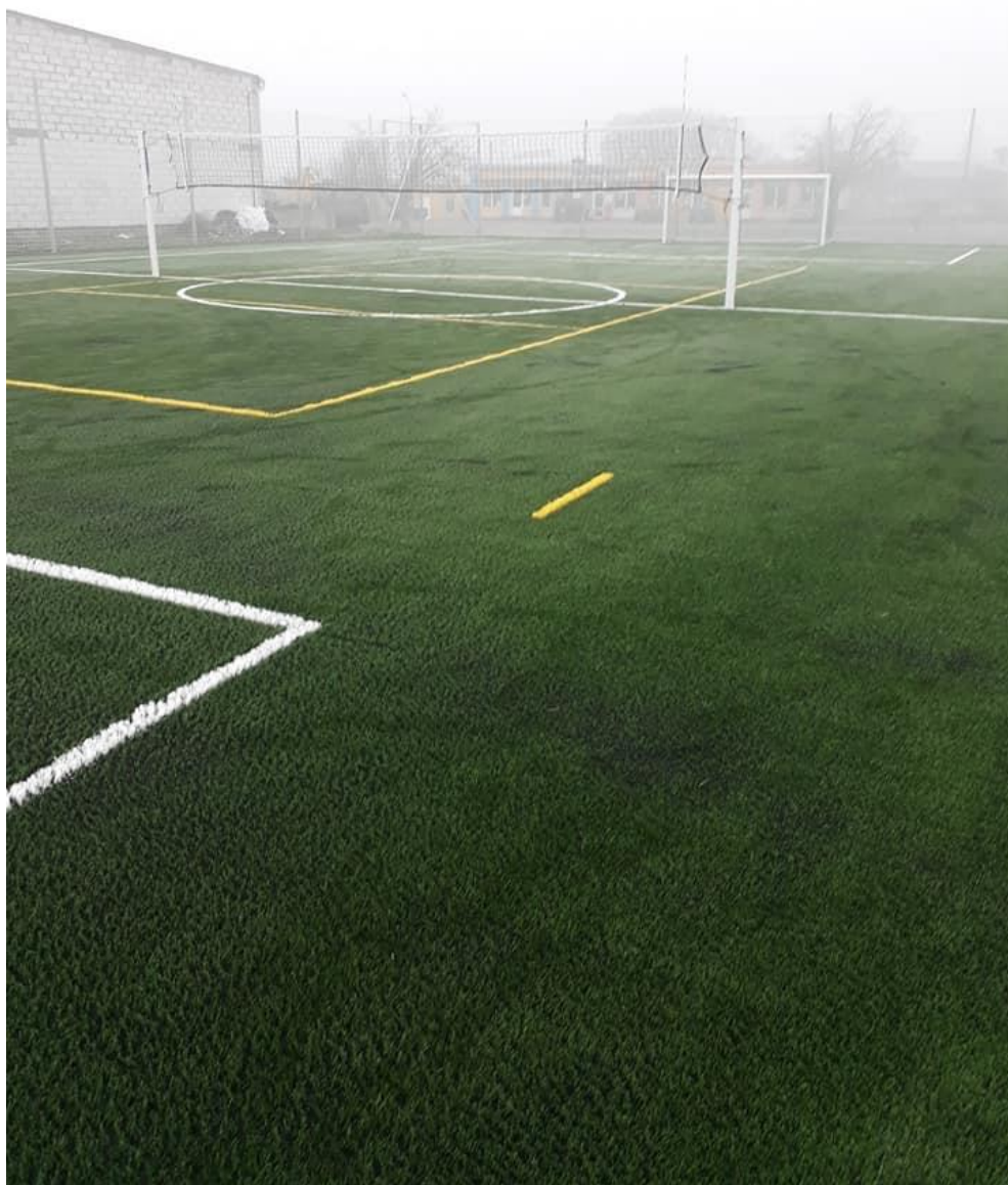
Budowa boiska wielofunkcyjnego w miejscowości Konopki
