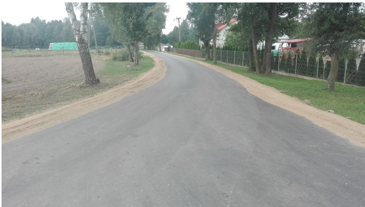
Przebudowa drogi gminnej Nr 230601W relacji Żmijewo Kościelne - Olszewo Bołaki
