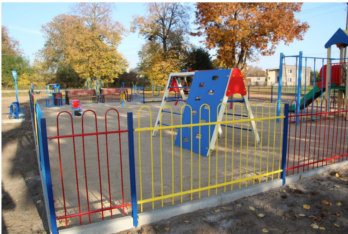
Budowa wielopokoleniowej strefy aktywności w miejscowości Stupsk
