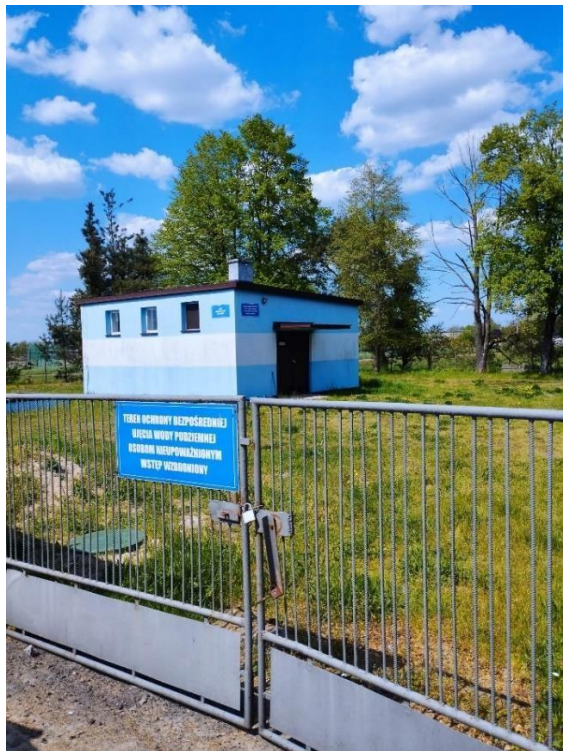
Rysunek 5 Stacja Uzdatniania Wody w Czajkowie
