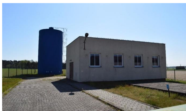
Rysunek 6 Stacja Uzdatniania Wody w Muchach
