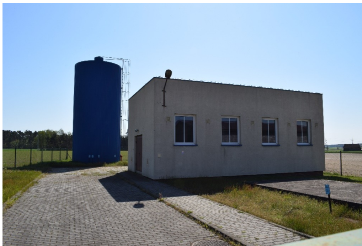
zdj. Stacja Uzdatniana Wody w Muchach
