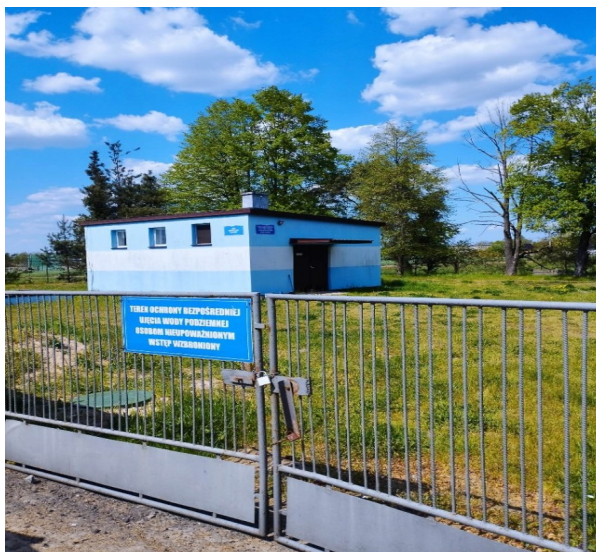
zdj. Stacja Uzdatniania Wody w Czajkowie
