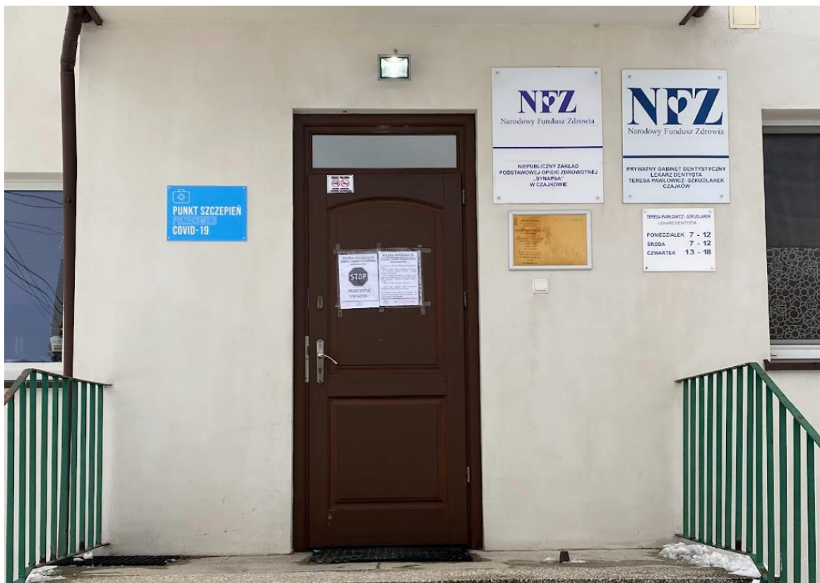
Fotografia 4.4 Element utrudniający bezpieczne dojście do budynku
