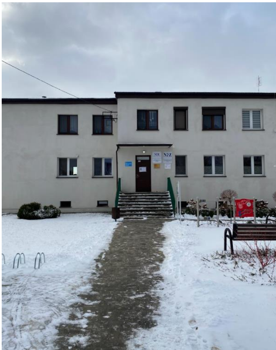
Fotografia 4.1 Droga prowadząca do głównego wejścia
