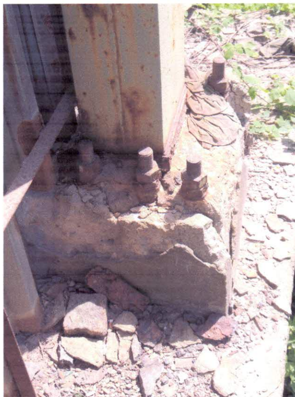
Fot. Z3-23. Fundament podpory słupowej S14 od strony ul. Fabrycznej, cios północny – zaawansowana degradacja betonu ciosów i ekspozycja kotew stalowych.
