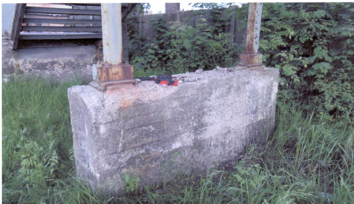
Fot. Z3-24. Fundament podpory słupowej schodów od strony ul. Fabrycznej – widoczna zaawansowana degradacja betonu ciosów i degradacja powierzchniowa betonu korpusu.
