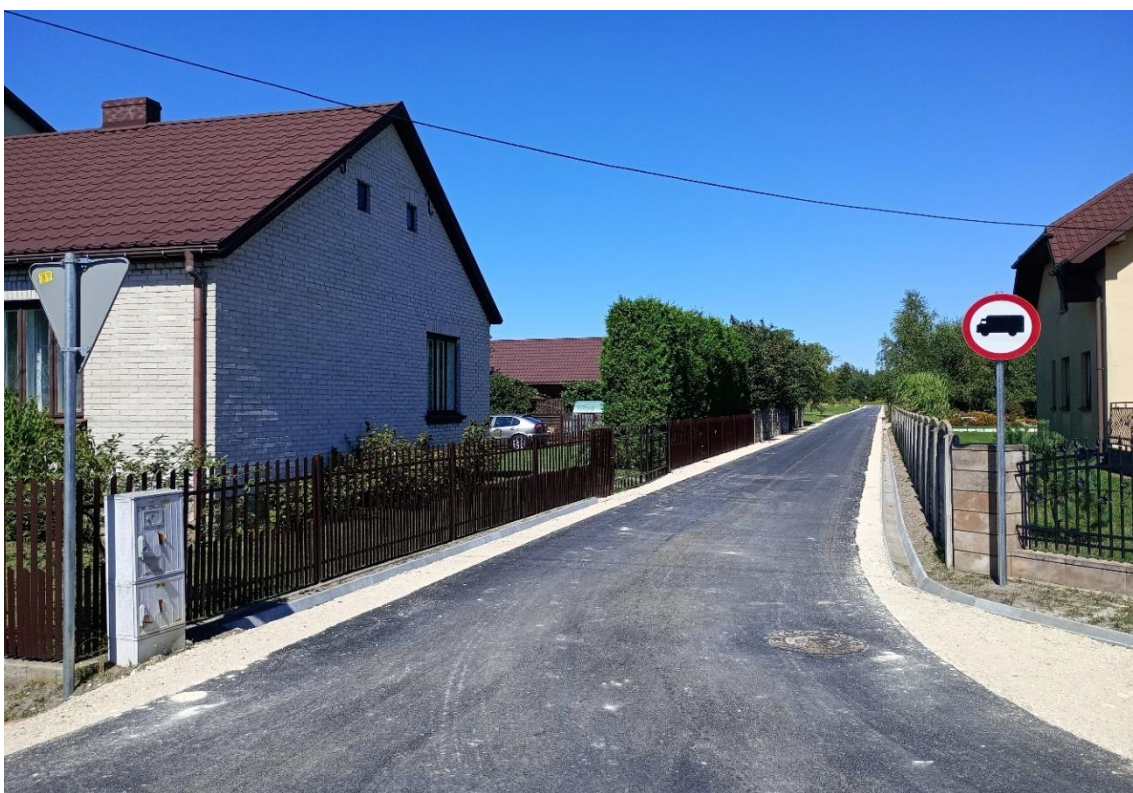
Fot: Przebudowa ul. Spokojnej w Nowym Kazanowie
