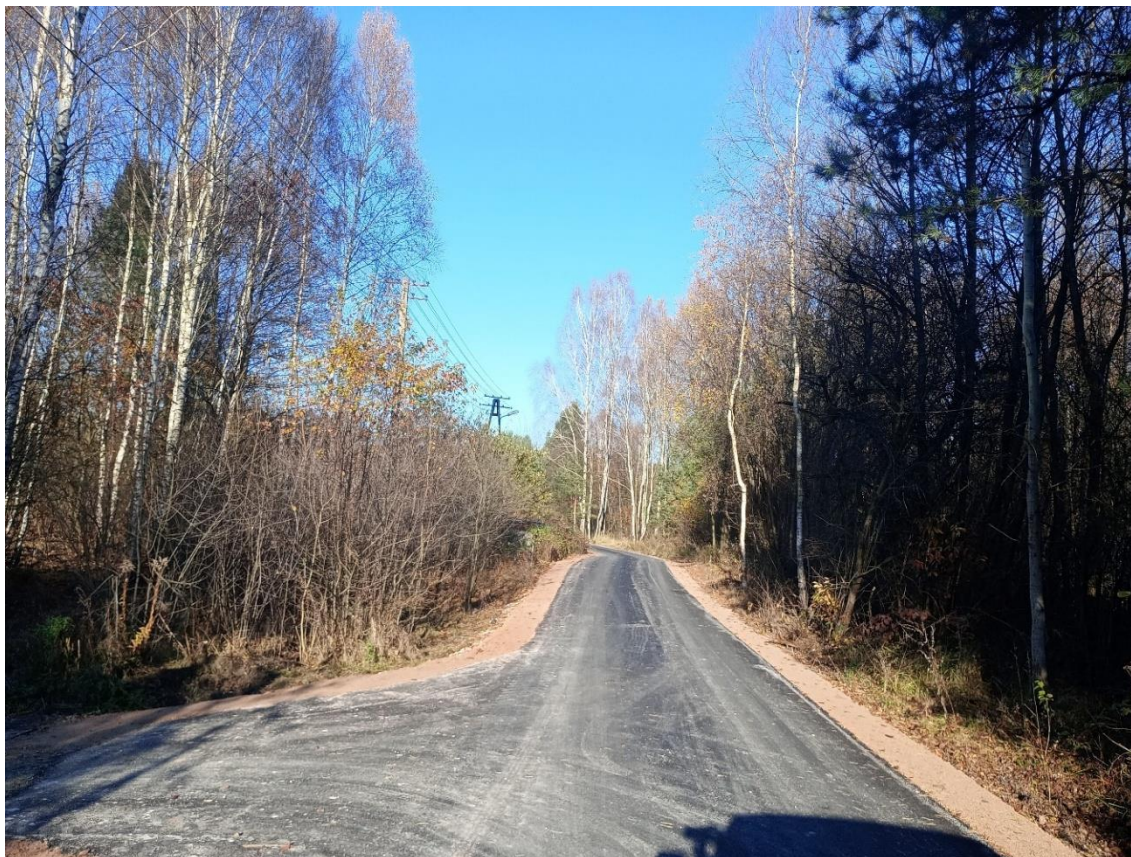
Fot: Przebudowa drogi wewnętrznej w m. Chelb
