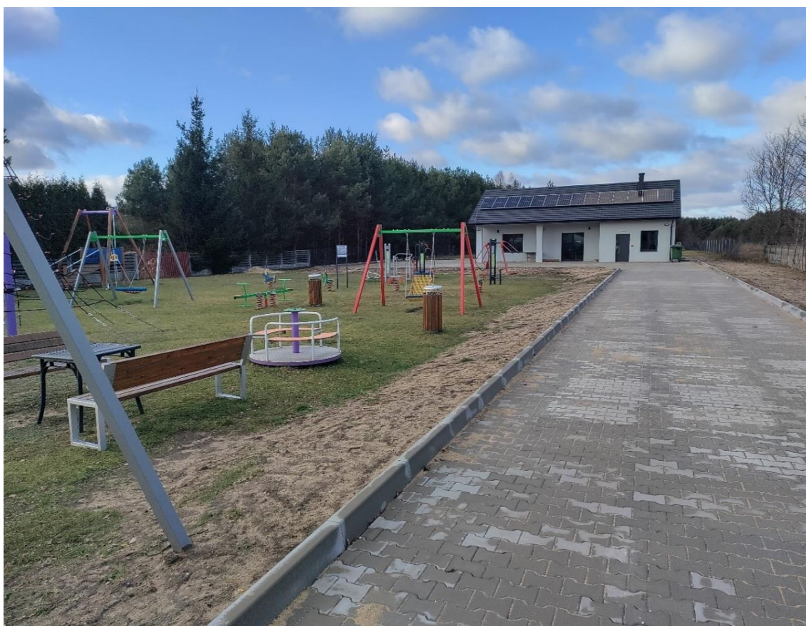
Fot: Świetlica w Gatnikach
