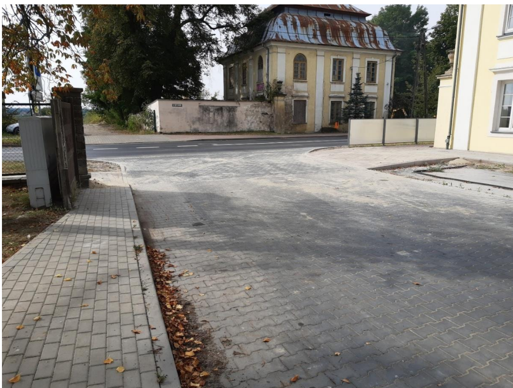
Fot: Przebudowa zjazdu na drogę krajową nr 42
