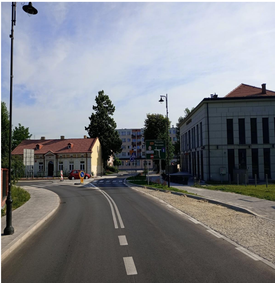
Fot: Przebudowa skrzyżowania dróg gminnych ul. Piłsudskiego, Mieszka I i ks. Granata z drogą wojewódzką nr 749 ul. Iwo Odrowąża i Zamkową w Końskich.
