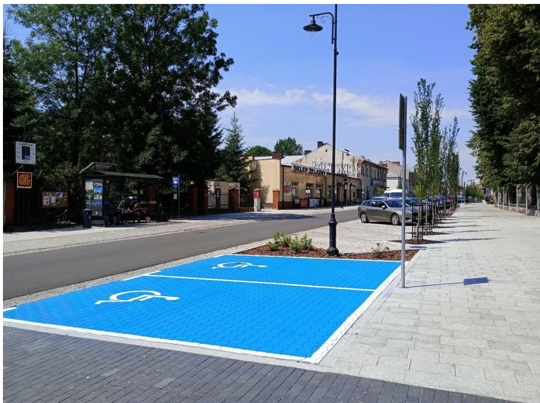
Fot: Budowa miejsc parkingowych z kostki granitowej, przy ul. Ks. Granata w Końskich
