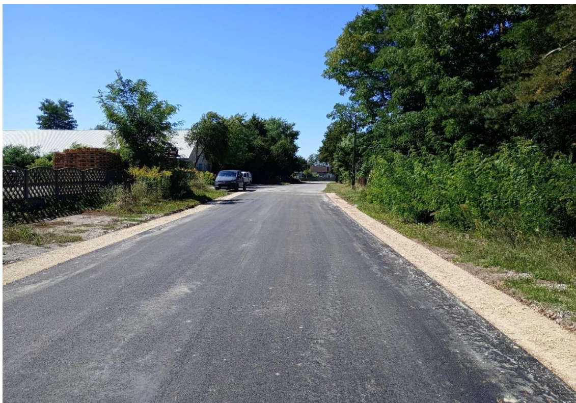
Fot: Przebudowa ul. Leśnej w Rogowie
