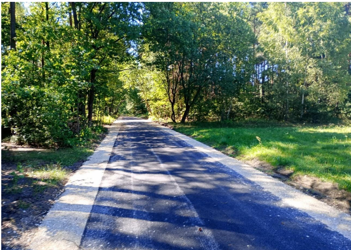
Fot: Przebudowa drogi wewnętrznej w Izabelowie
