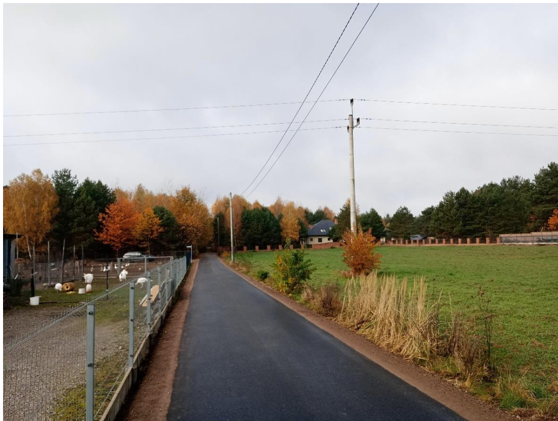
Fot: Przebudowa ul. Satynowej w Wincentowie
