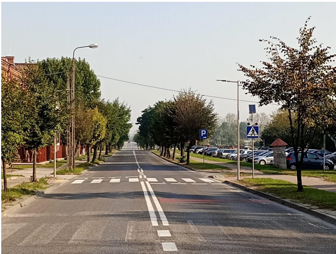
Fot: Przebudowa przejścia dla pieszych przy ul. Warszawskiej w Końskich
