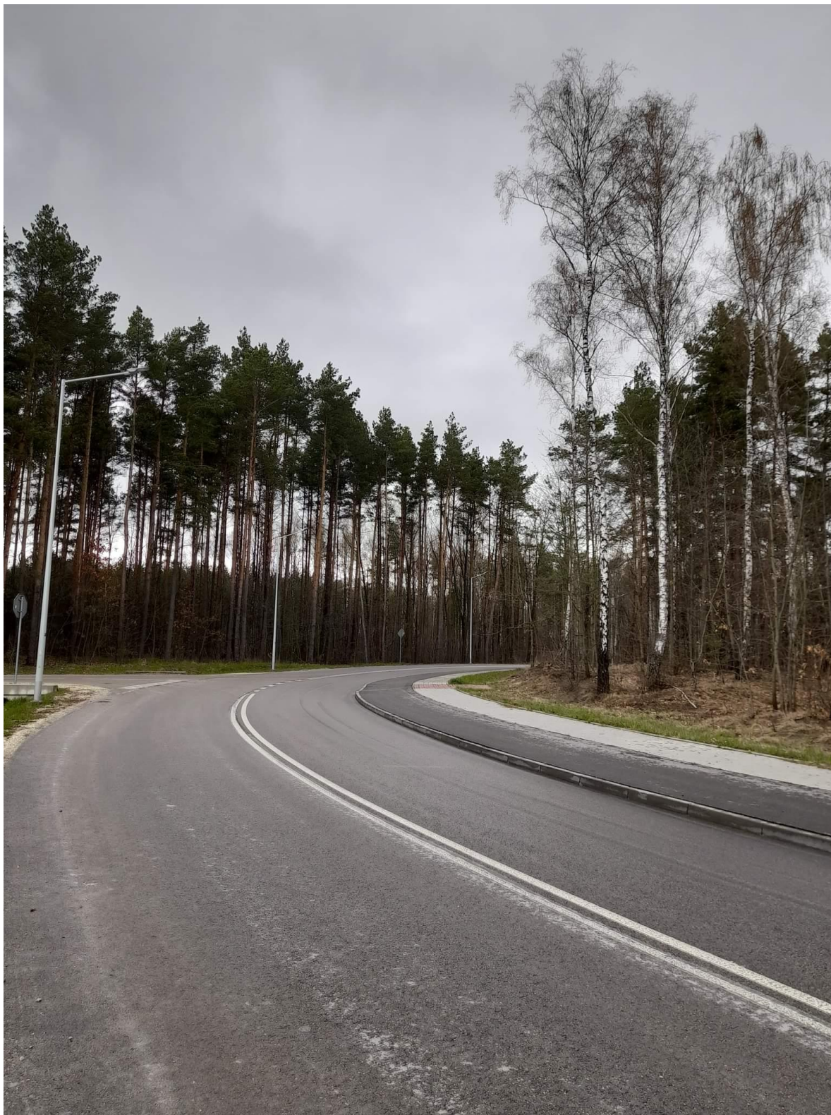
Fot.5,6,7,8 Droga łącząca ul. Spacerową z Kielecką z przebudowanym skrzyżowaniem
