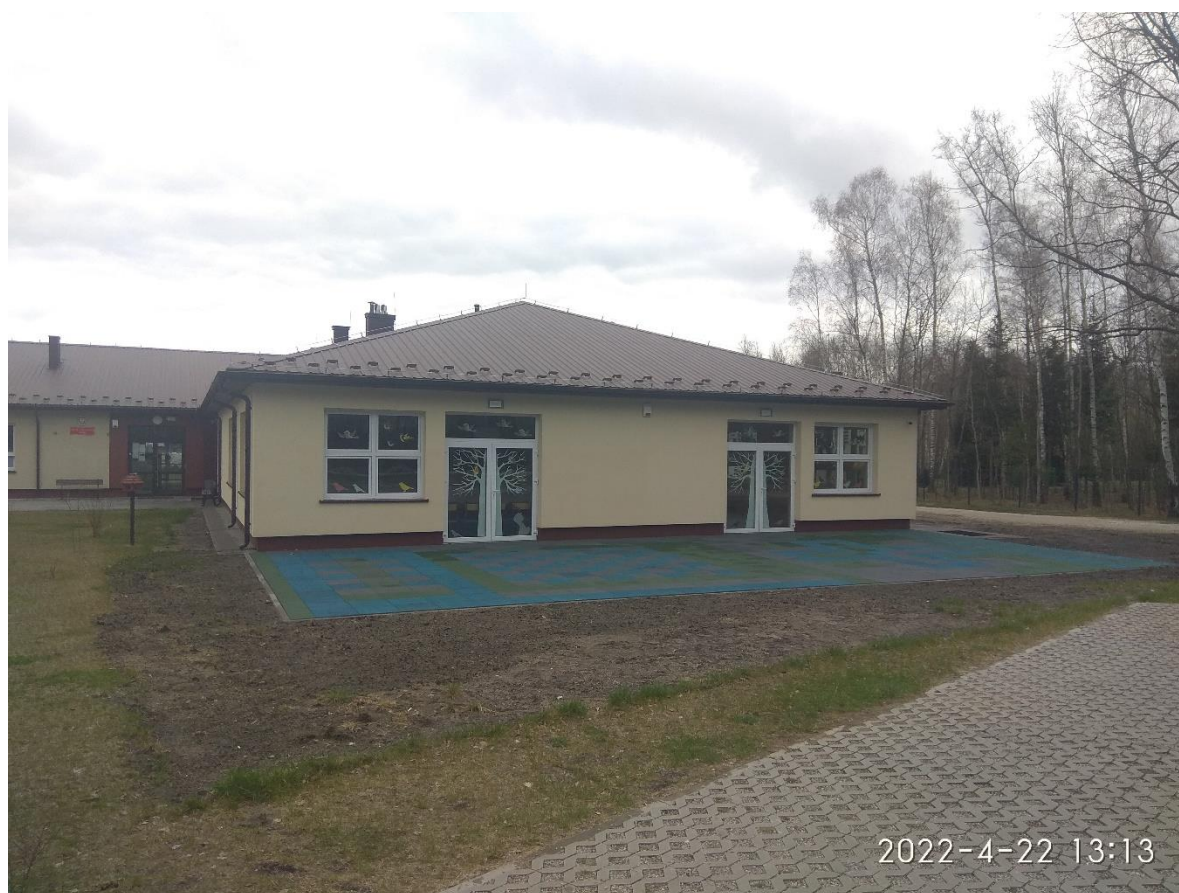
Fot. 13,14,15 "Szyty na miarę" budynek nowego przedszkola i jego wnętrza
