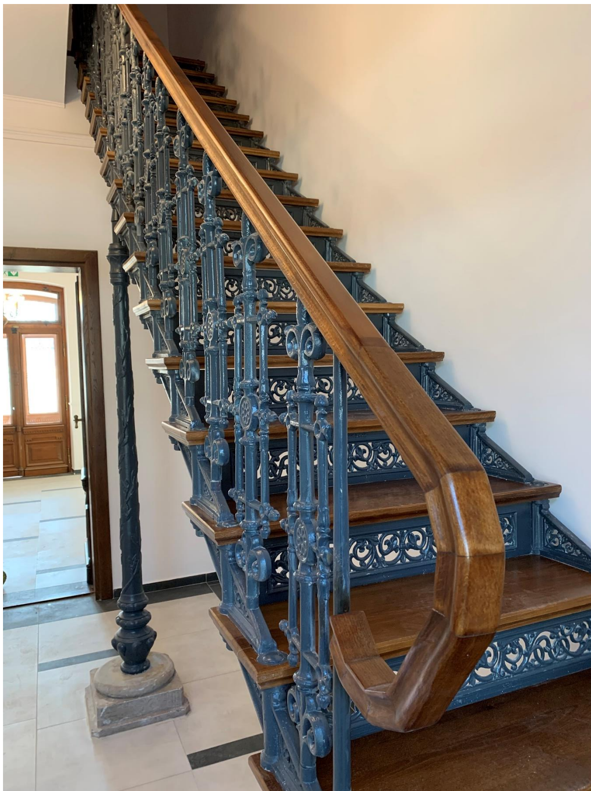
Fot. 1Żeliwne schody na poddasze po renowacji
