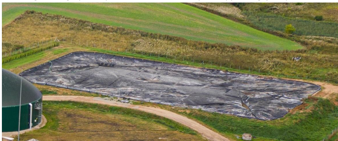
Fot. 5 Laguna magazynowa pofermentu – zbiornik wykonany jako zagłębiony w terenie
