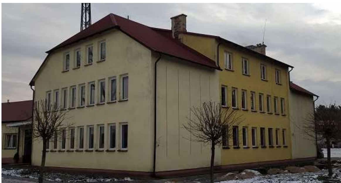
Rys. 12. Dach części głównej
