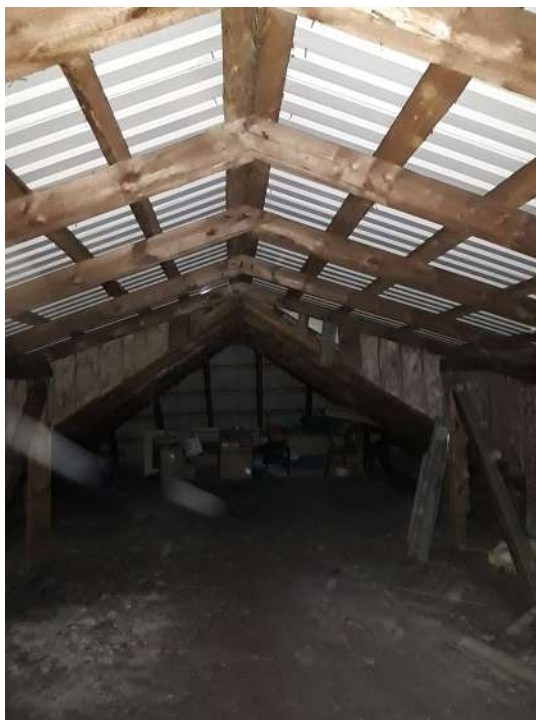
Rys. 11. Dach części głównej
