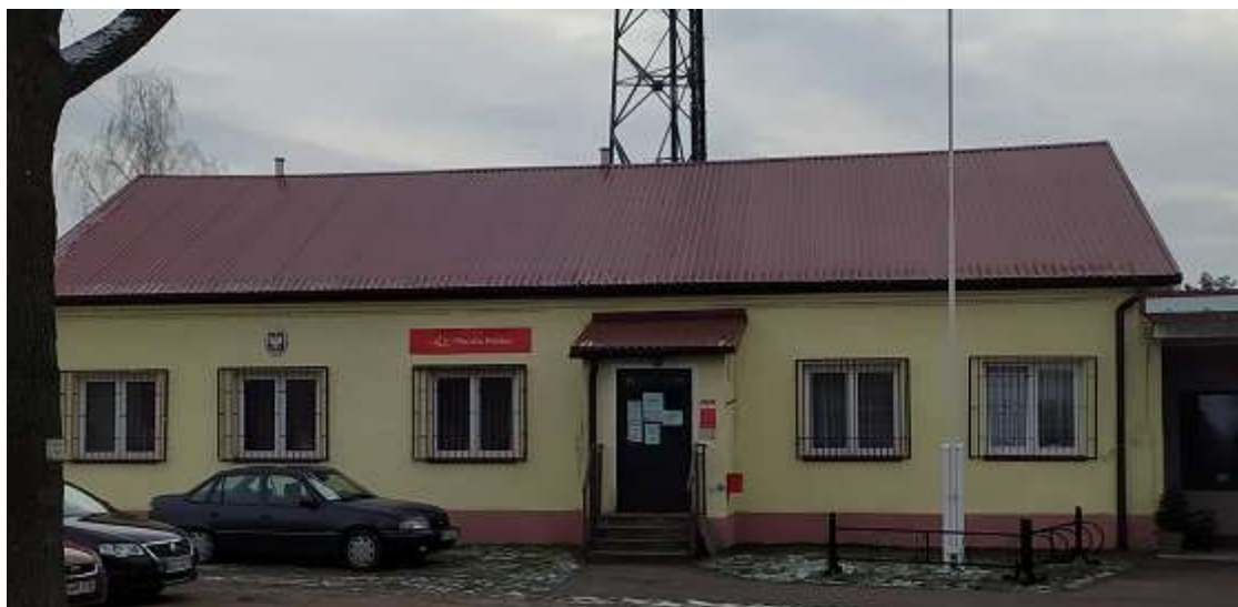
Rys. 9. Dach części parterowej
