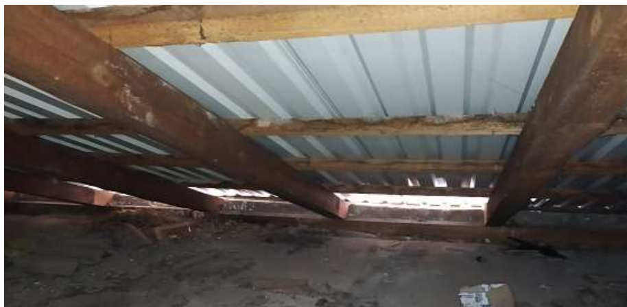
Rys. 10. Dach części parterowej
