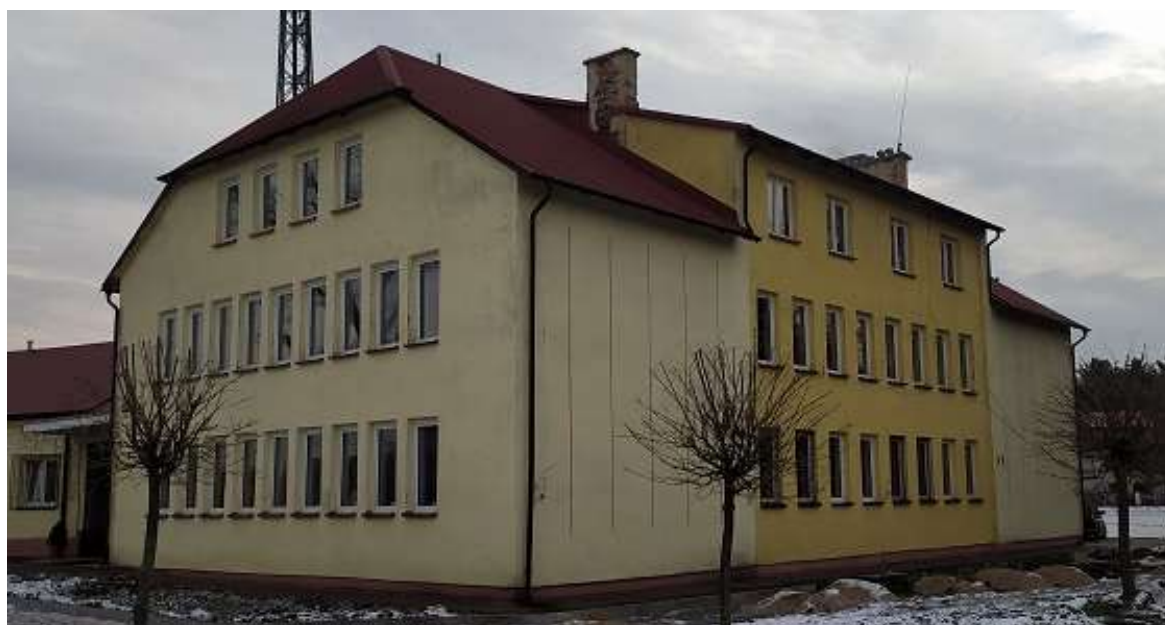
Rys. 12. Dach części głównej
