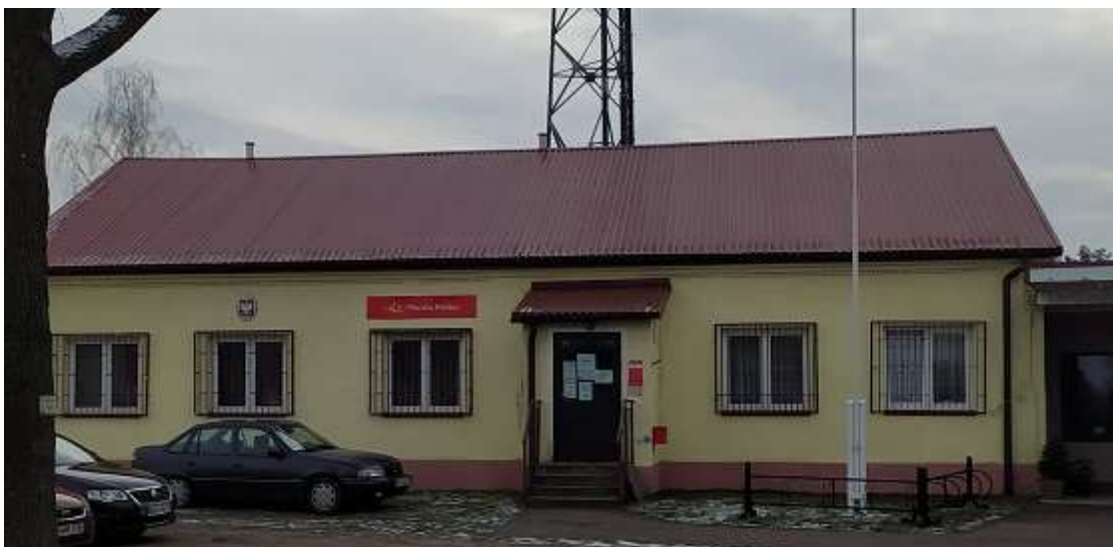
Rys. 9. Dach części parterowej
