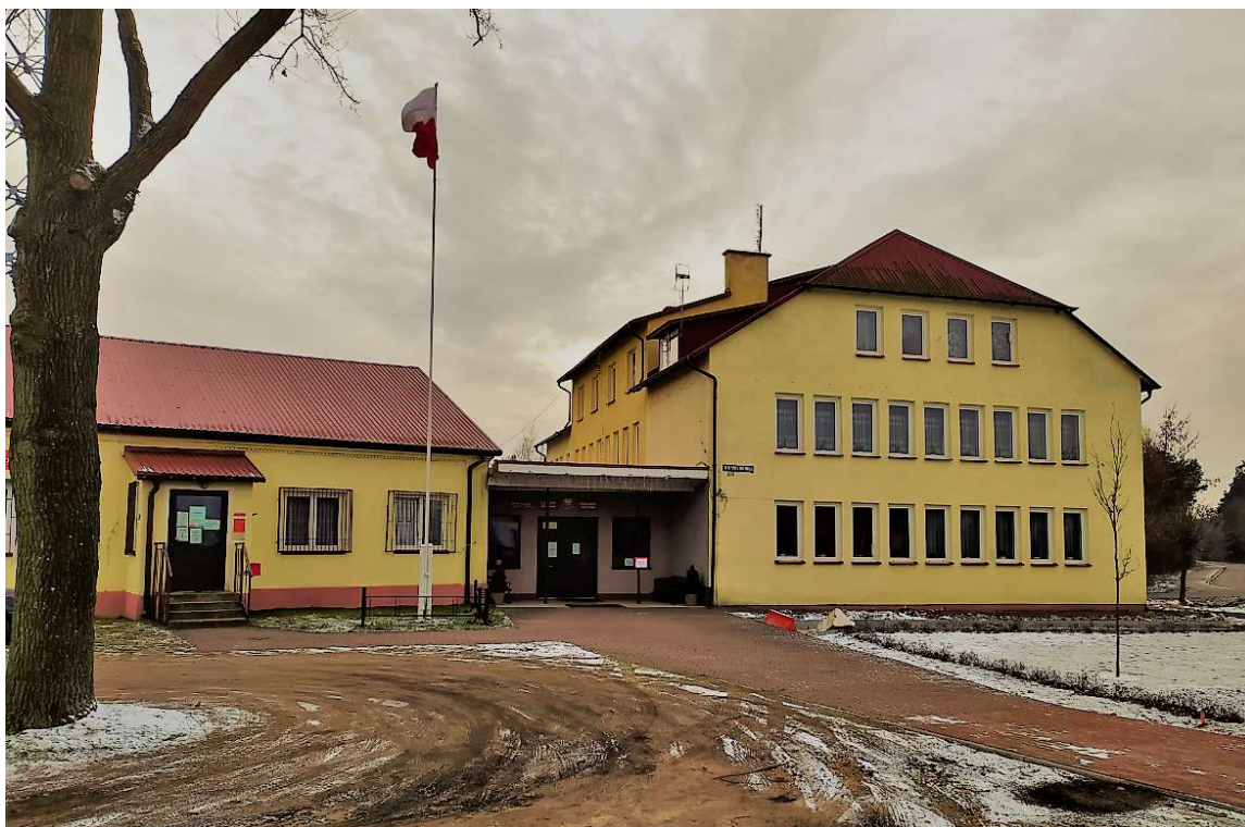
Rys. 3. Elewacja frontowa budynku
