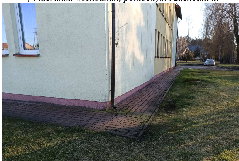
-widok na teren od strony zachodniej budynku
