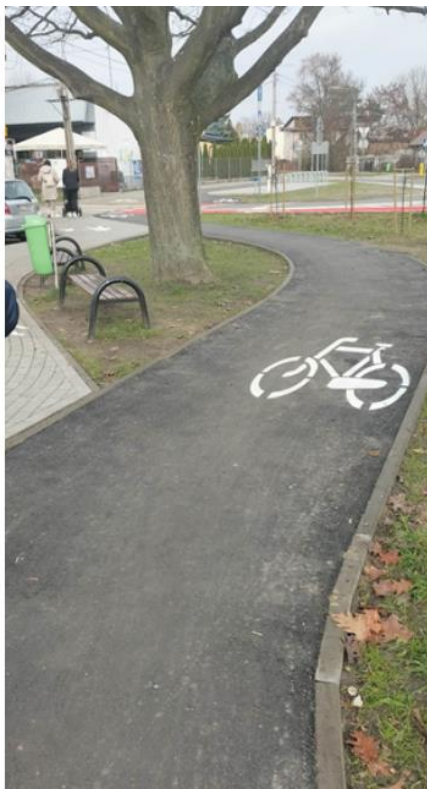
ul. Bohaterów Ossowa na odc. Rondo Cudu nad Wisłą – Broniewskiego
