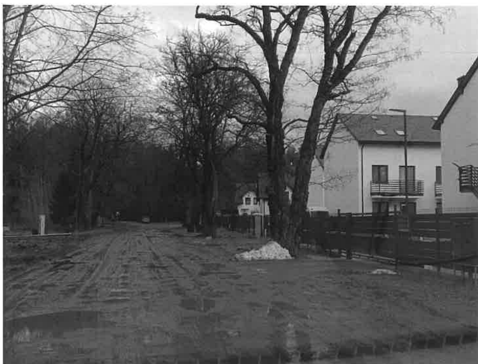
Zdj. 2: ul. Kraszewska – widok w stronę granicy lasu oraz na wjazd na osiedle nr
