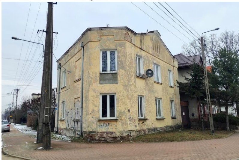
Zdjęcie nr 10. Kamieniczka, ul. Orszagha 2
