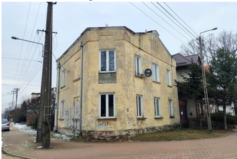
Zdjęcie nr 10. Kamieniczka, ul. Orszagha 2
