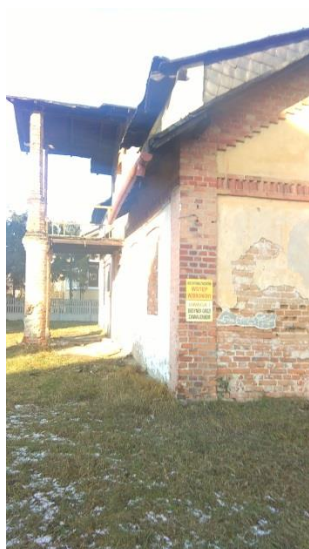
Zdjęcie 3. Budynek przy ul Rumuńskiej 2
