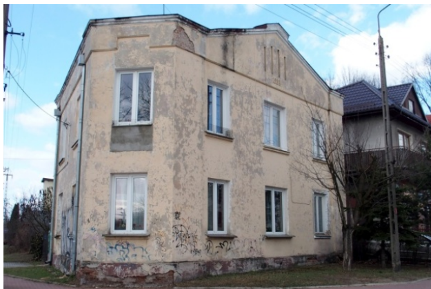
Zdjęcie nr 9. Kamieniczka, ul. Orszagha 2
