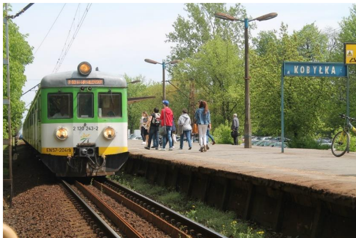
Rysunek 5. Stacja PKP Kobyłka – widok przed modernizacją rozpoczętą w 2015 roku
