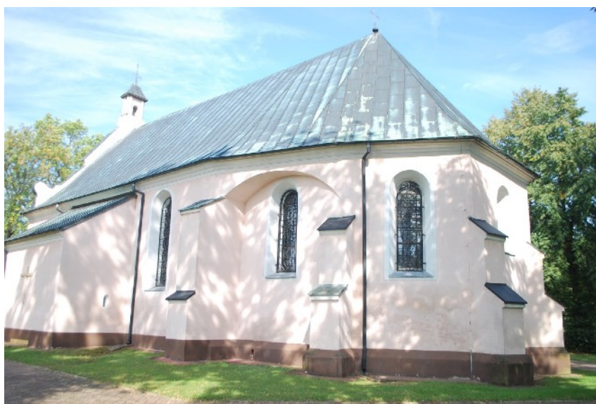
Fot. 2 Elewacja południowa
