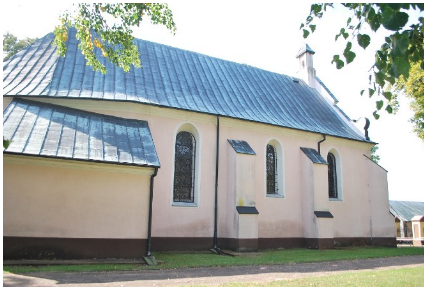
Fot. 3 Elewacja wschodnia
