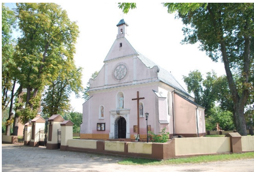
Fot. 1 Elewacja frontowa
