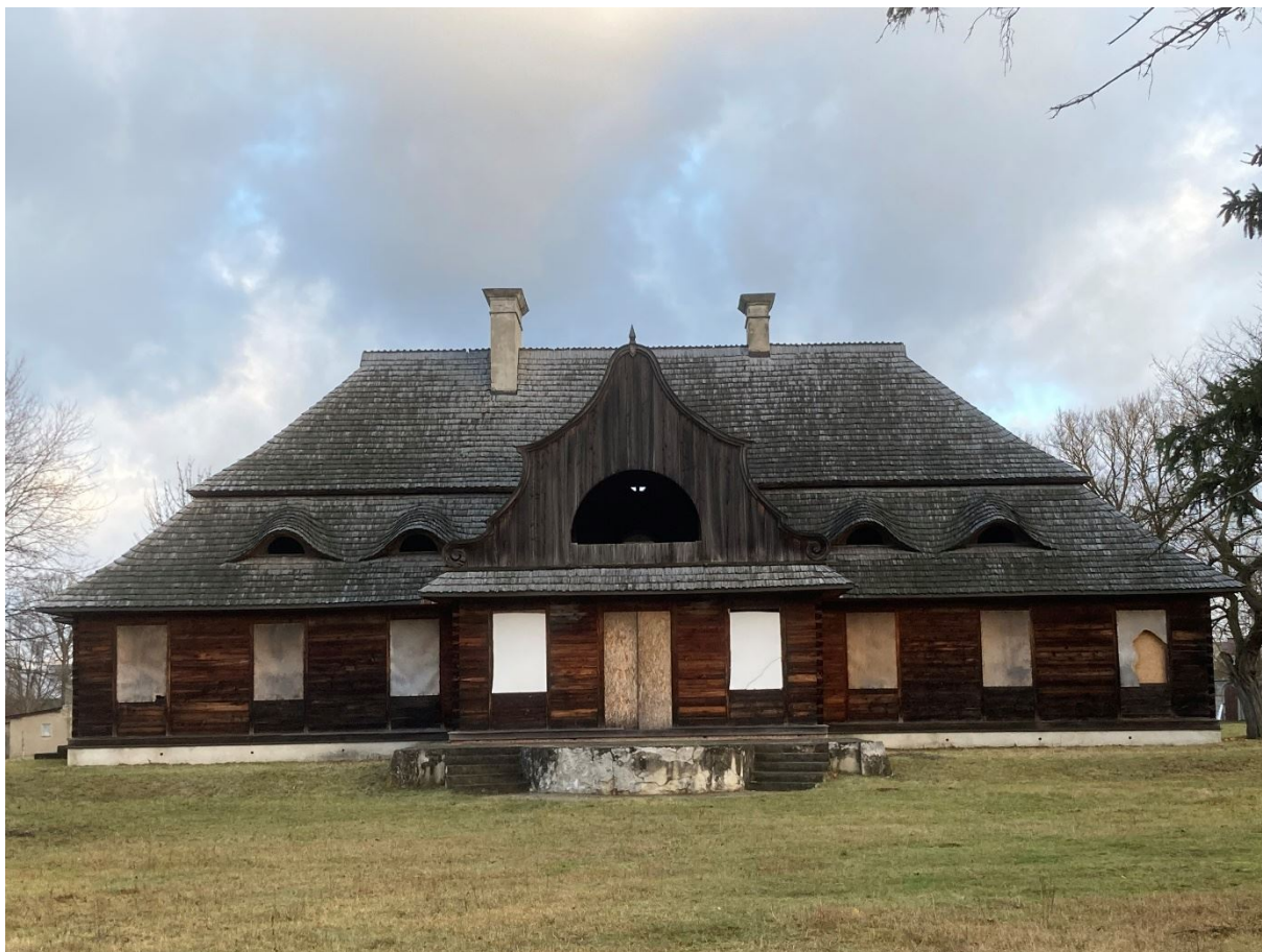
fot. Dziewiętnastowieczny dwór w Wodzieradach, elewacja południowa , fot. P. Pawlak
