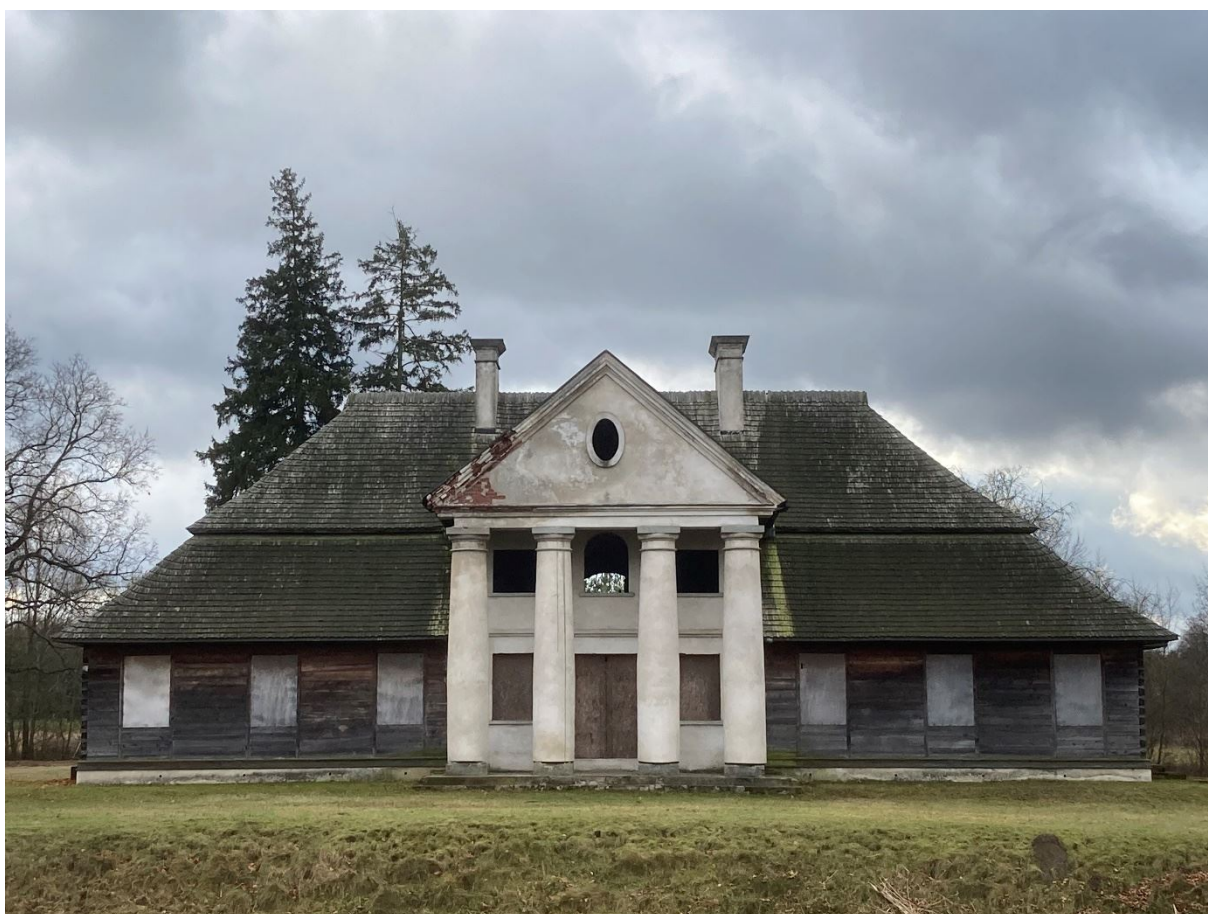
Dziewiętnastowieczny dwór w Wodzieradach, elewacja północna , fot. P. Pawlak
