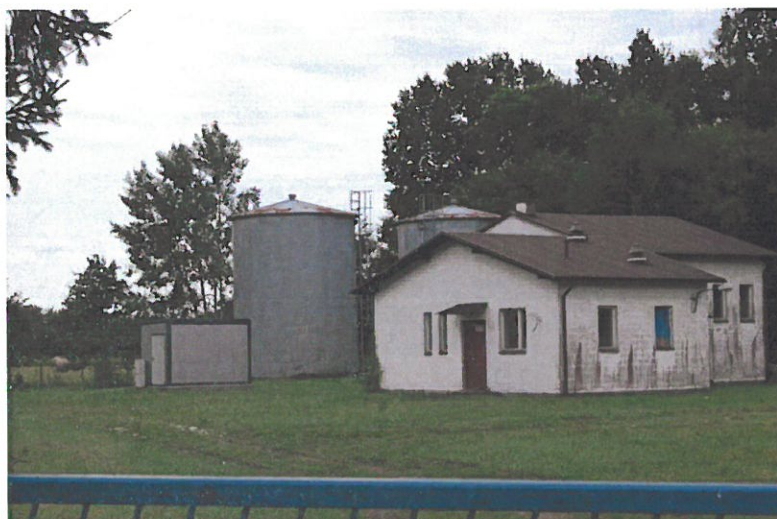
Stacja uzdatniania wody – Koziarnia
