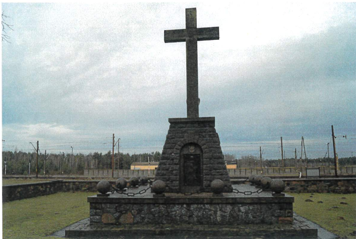
Fot. nr 3. Mauzoleum Legionistów w Brzustowie – widok na pomnik-Mauzoleum od strony południowej.
