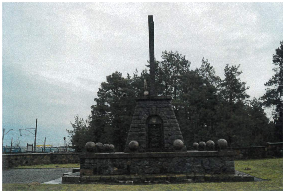
Fot. nr 16. Mauzoleum Legionistów w Brzustowie – Widok pomnika od strony zachodniej z ukazaniem zapadnięciem narożnika prawego i korozją biologiczną kamienia
