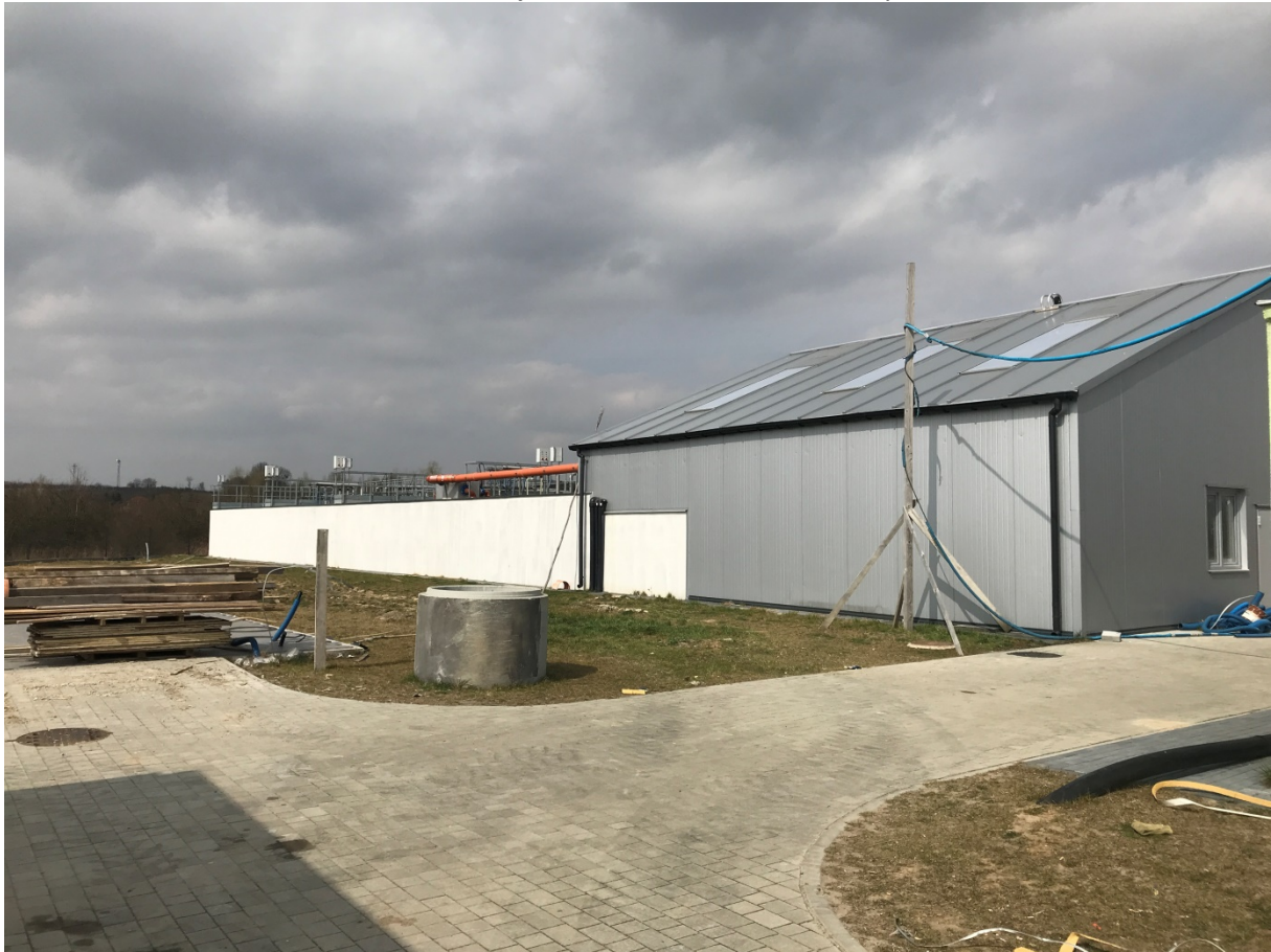
Przykładowa realizacja oczyszczalni
