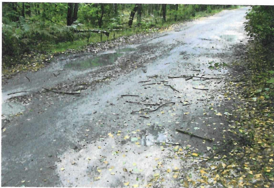
Fot. 3 Wybiórcze naprawianie dziur, zasypane i nie zasypane dziury materiałem o bardzo zróżnicowanym uziarnieniu
